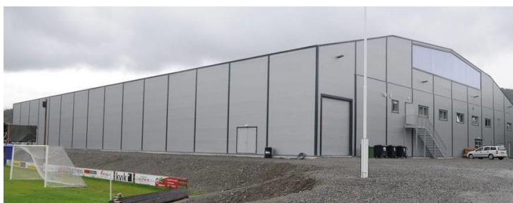
Figur 4.4: Utenfor testobjekt 2. Utarbeidet fra innherred.no [44]
