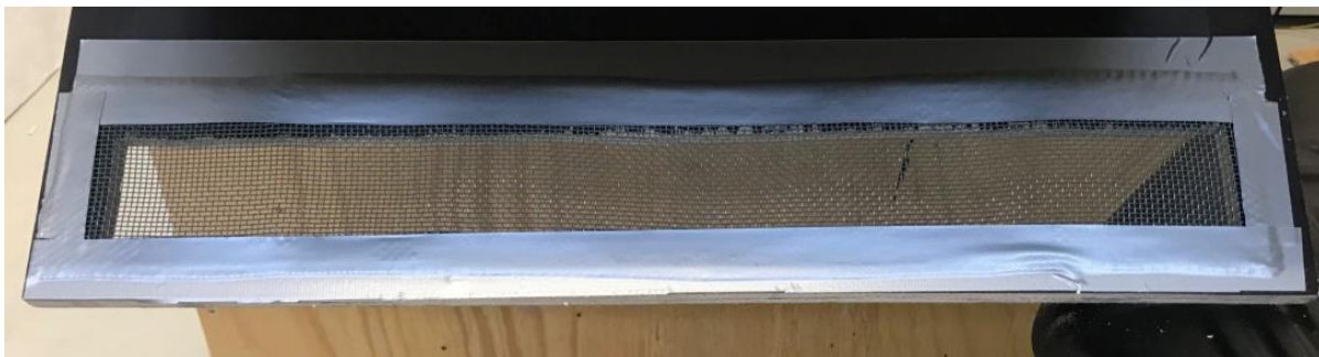
Figur 4.7 Nett 1 montert over spalteaåpningen i raftekassen
