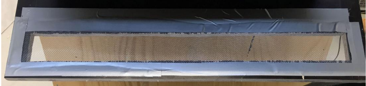
Figur 4.8 Nett 2 montert over spalteåpningen i raftekassen
