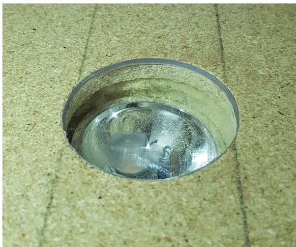
Figur 3.12 Lexan over LED pære i takplanet
