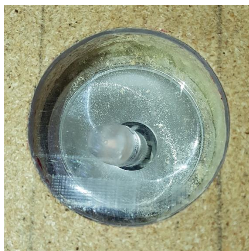
Figur 3.13 LED pære og reflektor under lexan
