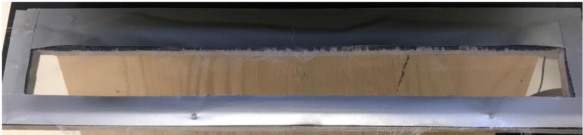
Figur 4.9 Nett 3 montert over spalteåpningen i raftekassen
