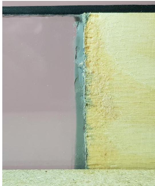
Figur 3.15 Sparklet overgang mellom lexan og Takboks 2
