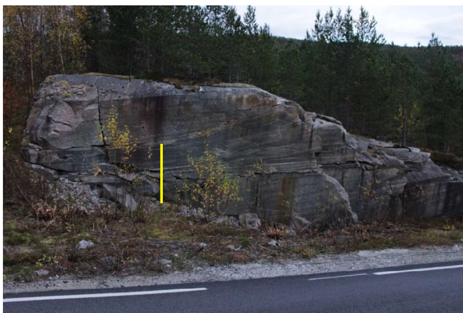
Figur 3.16 – Lokalitet 5: Oppsprekking langs sprekkeseett 1. Skjæringen ligner på eksempelet gitt av Myrvang (2001) av eksfoliasjonssprekker. Bildet er tatt mot øst, og gul målestokk er 2 meter lang.
