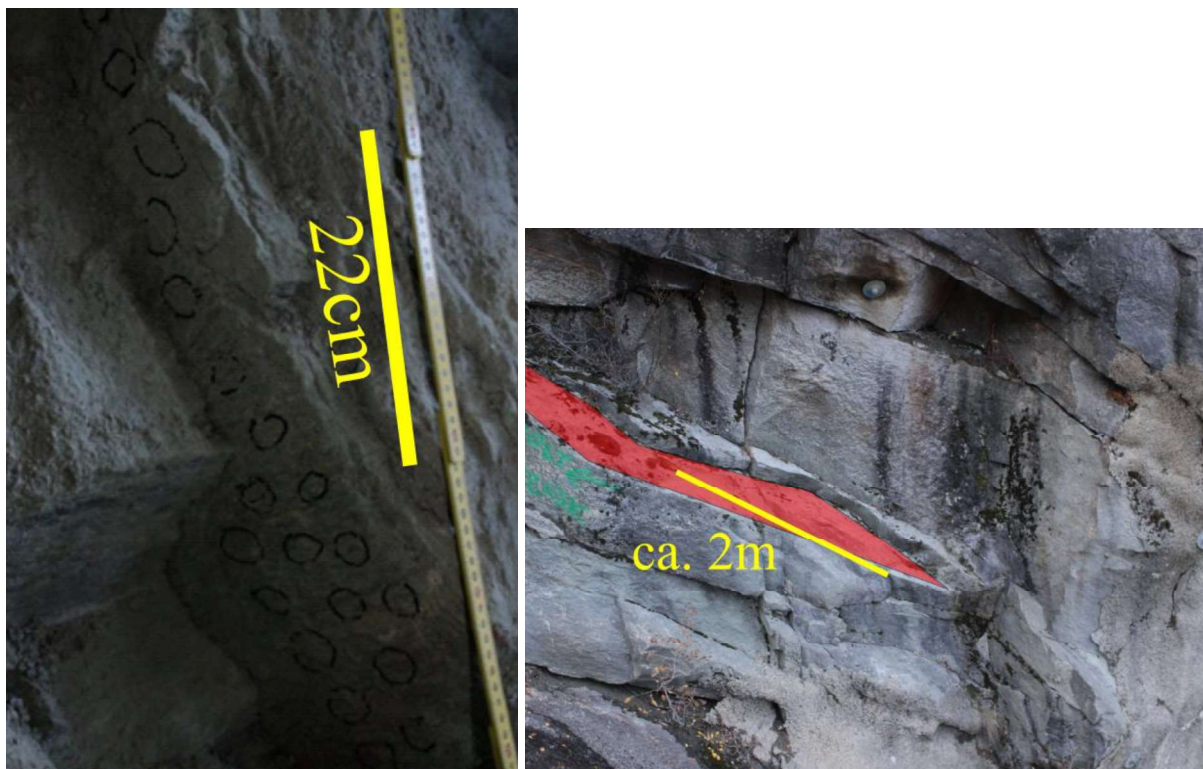
Figur 3.39 – Sprekkeflater som ble målt for JRC og JCS.
