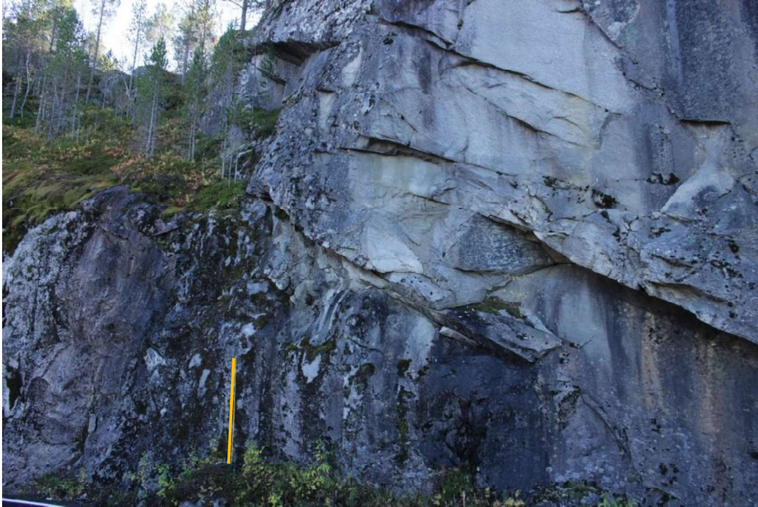
Figur 3.28 - Lokalitet 12: Formen på kløften som dannes av svakhetssonen indikerer at svakhetssonen faller på skrå mot høyre i bildet. Vanligvis faller knusingssonene inn under bratteste side. Bildet er tatt fra omkjøringsvegen like nord for lokalitet 12. Bildets retning er sørover mot lokalitet 12. Gul målestokk er 2 meter lang.
