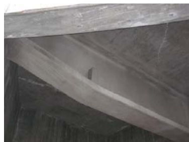
Lysaker lokket E18. CemPro Topcoat på CemPro Fireshield 1150. Brannsikring av stålkonstruksjoner.
