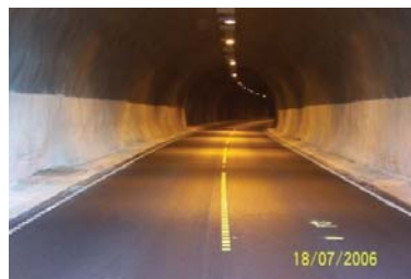
CemPro Whitecoat i AGA tunnelen
