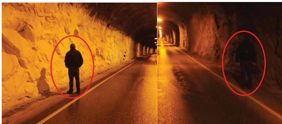
Figur 15 Sammenligning - økt synbarhet av person i tunnel grunnet økt kontrast
