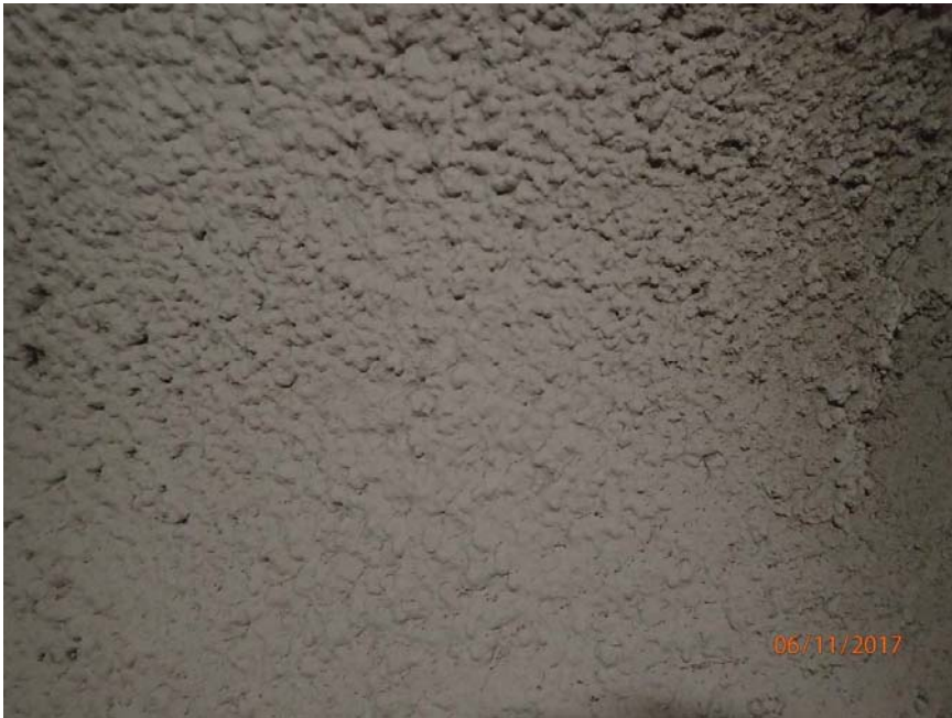
Figur 11 Nærbilde av overflatebehandling på sprøytebetong i Vethaugtunnelen
