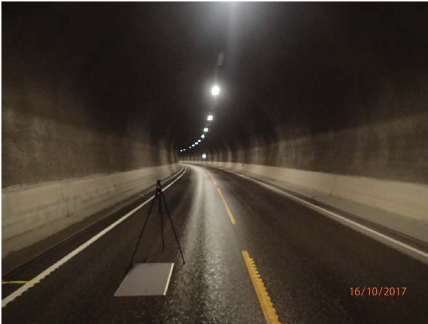
Figur 7 Vethaugtunnelen før overflatebehandling
