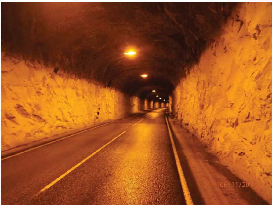
Figur 10 Sundsfjordtunnelen etter overflatebehandling
