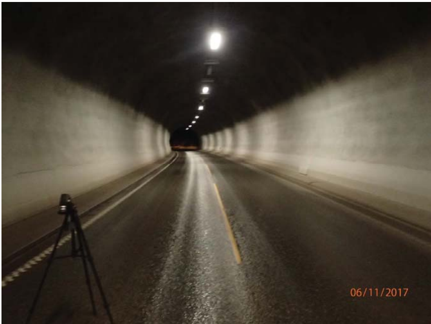
Figur 8 Vethaugtunnelen etter overflatebehandling
