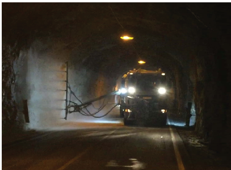
Figur 5 Sprøyting i Sundsfjordtunnelen 25.10.2018 (foto: Alf Magne Helland, Statens vegvesen)
