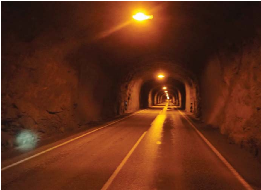
Figur 9 Sundsfjordtunnelen før overflatebehandling
