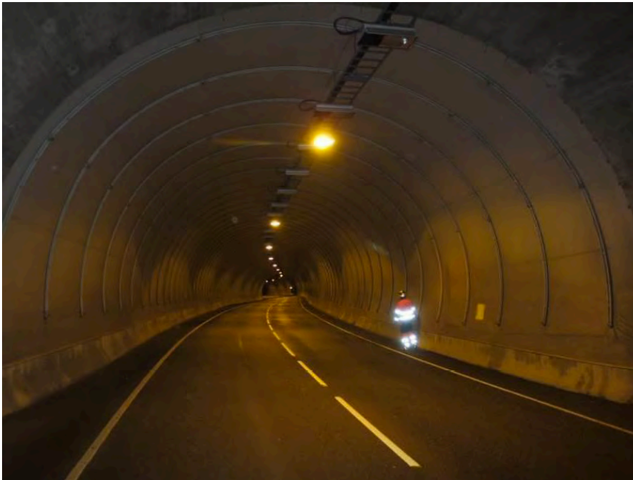
Figur 21: Ferdig WG tunnelhvelv T100 hvor man kan se rørbuene som holder tunnelduken på plass (Rønneberg and Østmoen 2016).
