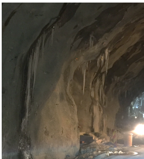
Figur 9: Illustrasjon av frost i tunneltverrsnitt før VoF i Eiganestunnelen (eget bilde)
