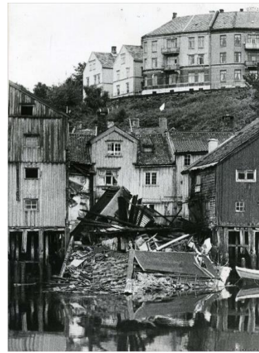
Figur 2.5: Nedre Bakklandet. Riving av brygge. Kilde: Trondheim byarkiv (1967).
