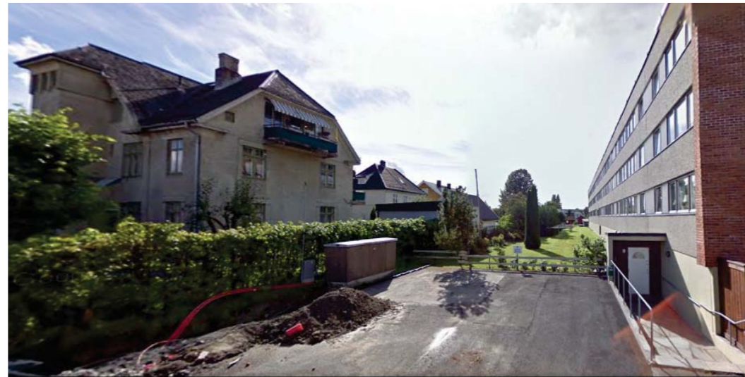
Gårdstret sett mot sør, mellom Hønefjordgata 34 og Parkgata 18.
