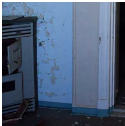
Oppvarming: én ovn står igjen innvendig. Radiatorer og alle andre ovner er fjernet.
