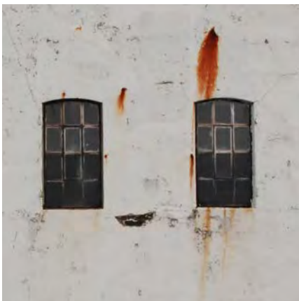
Støpejernsvinduer mot SV. Nedre del av støpejernsvinduet er kledd igjen på innsiden.
