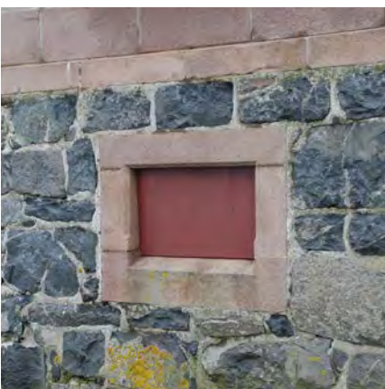
Vinduer 1: Gjenspikret kjellervindu, vegg mot NØ
