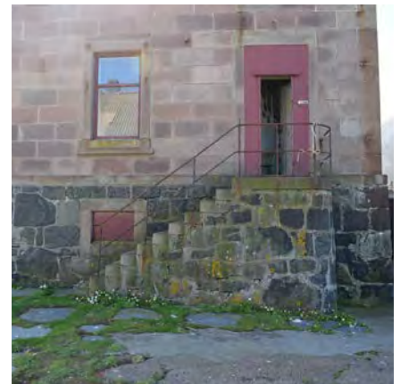
Trapper: hovedinngang. Gelender bør sikres.
