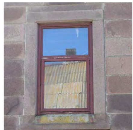
Vinduer 3): Topphengslet vindu, vegg mot NØ.
