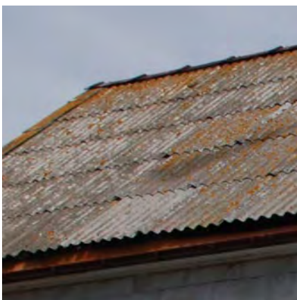
Taktekking: Eternittplater. Slitt, men bør ikke byttes ut før absolutt nødvendig.
