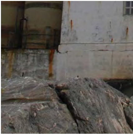
Fundament: grunnmur, vegg mot NV.
