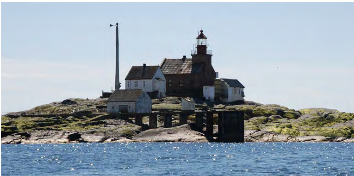
Fyrstasjonen sett fra nord
