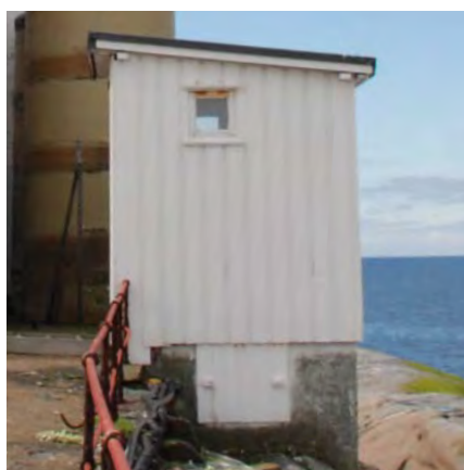
Øvre utedo: Fasade mot NØ. Nylig malt.
