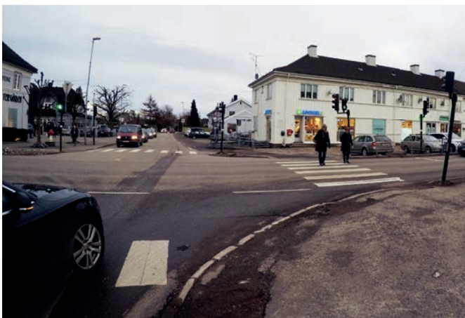
Figur 53: Lysregulert gangfelt over Smidsrødveien
