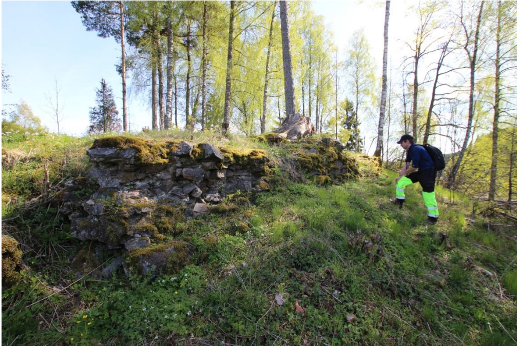
Fig.24 Ringmurparti i vest hvor mye av det ytre murskallet er revet ut. Foto tatt av RM.
