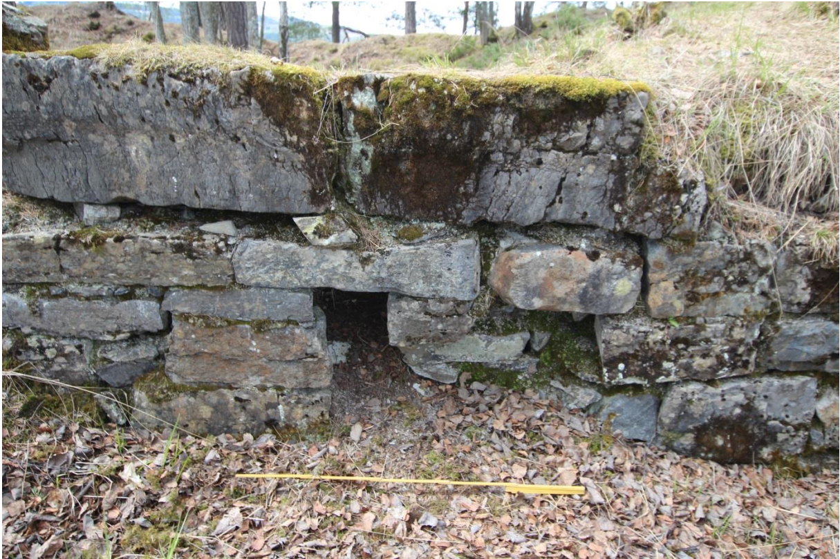
Fig.18 Åpning i vestmurens ytre murliv med skråsmyg tolket som vindusåpning. Foto tatt av RM.
