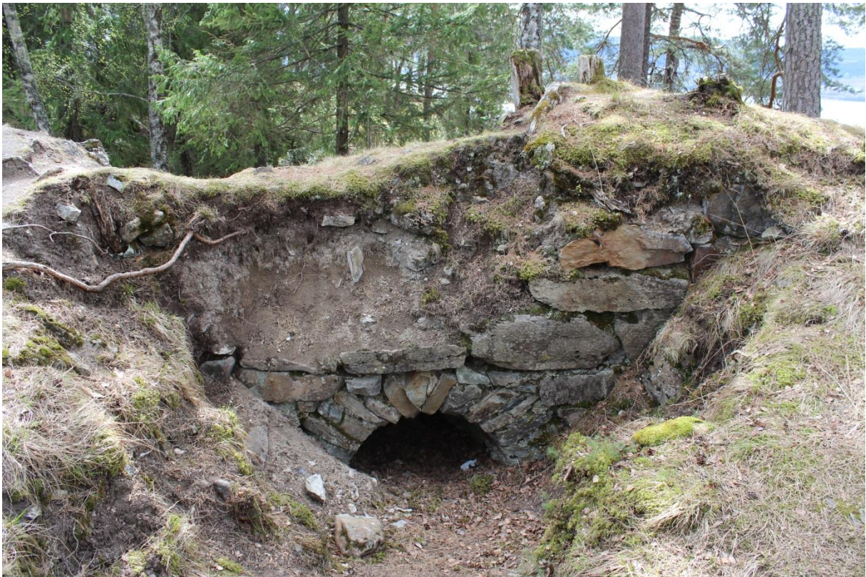
Fig.19 Rundbuet åpning i sørmurens indre murliv med skråsmyg tolket som vindusåpning. Foto tatt av RM.
