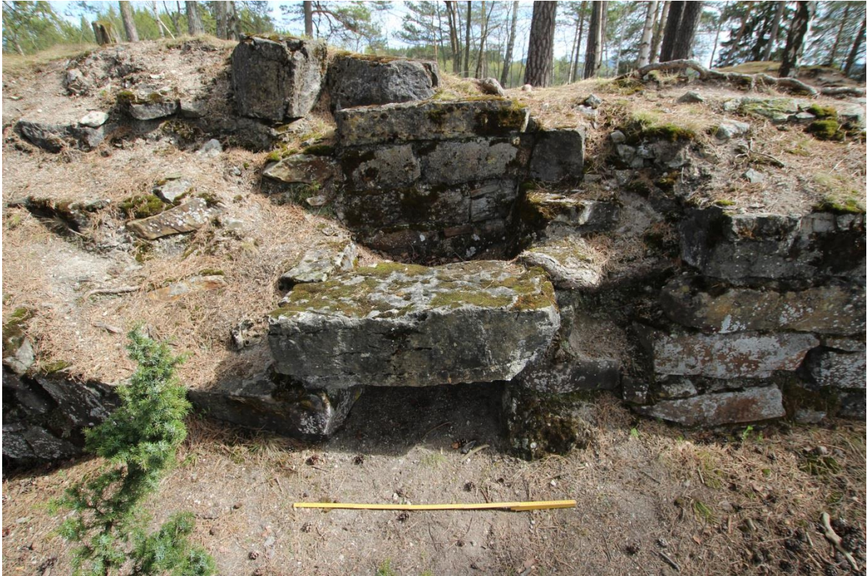
Fig.20 Åpning i vestmurens ytre murliv inn til vertikalsjakt i murverket. Dette kan være restene etter en latrinesjakt. Foto tatt av RM.
