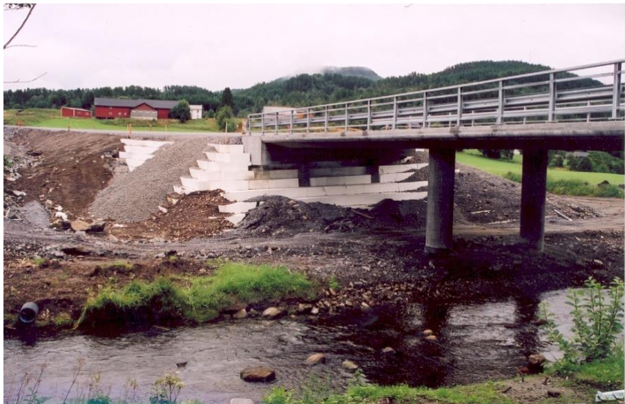
Figur 3: Varmeisolering av Betna bru (Foto: Tore Kvande).
