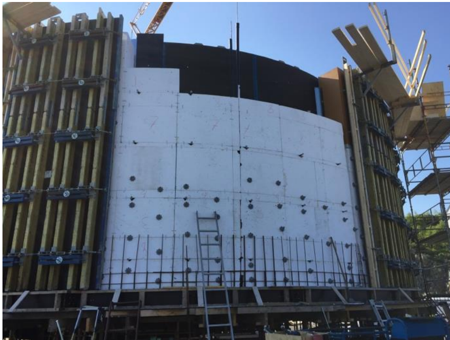
Figur 2: Fiskemerde med EPS-plater montert inni betongveggen (Foto: Terje Eknes)
