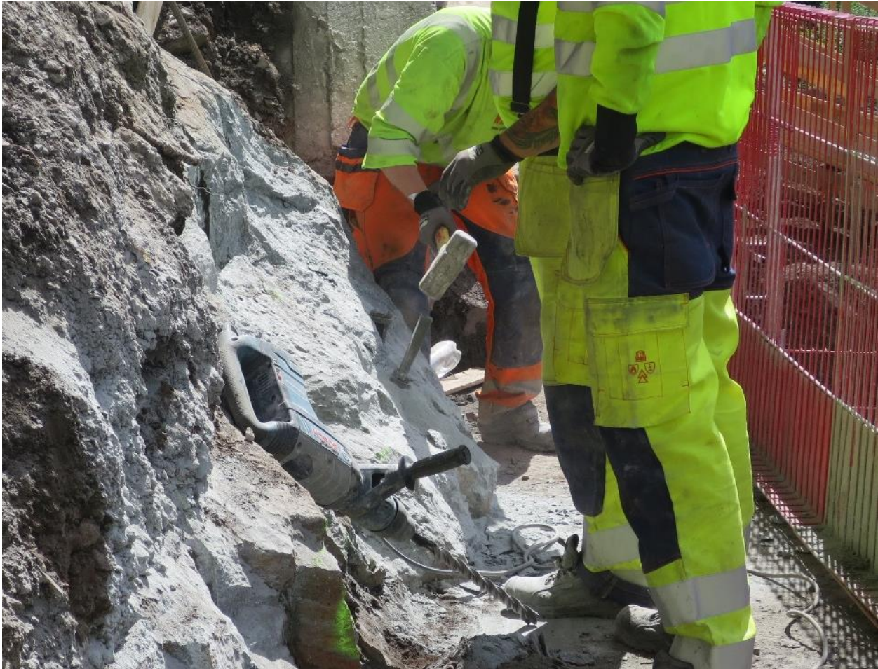
Figur 35 Splitting med kiler og slegge ved Søndre portal (Foto: T. K. Weydahl, 2017).
