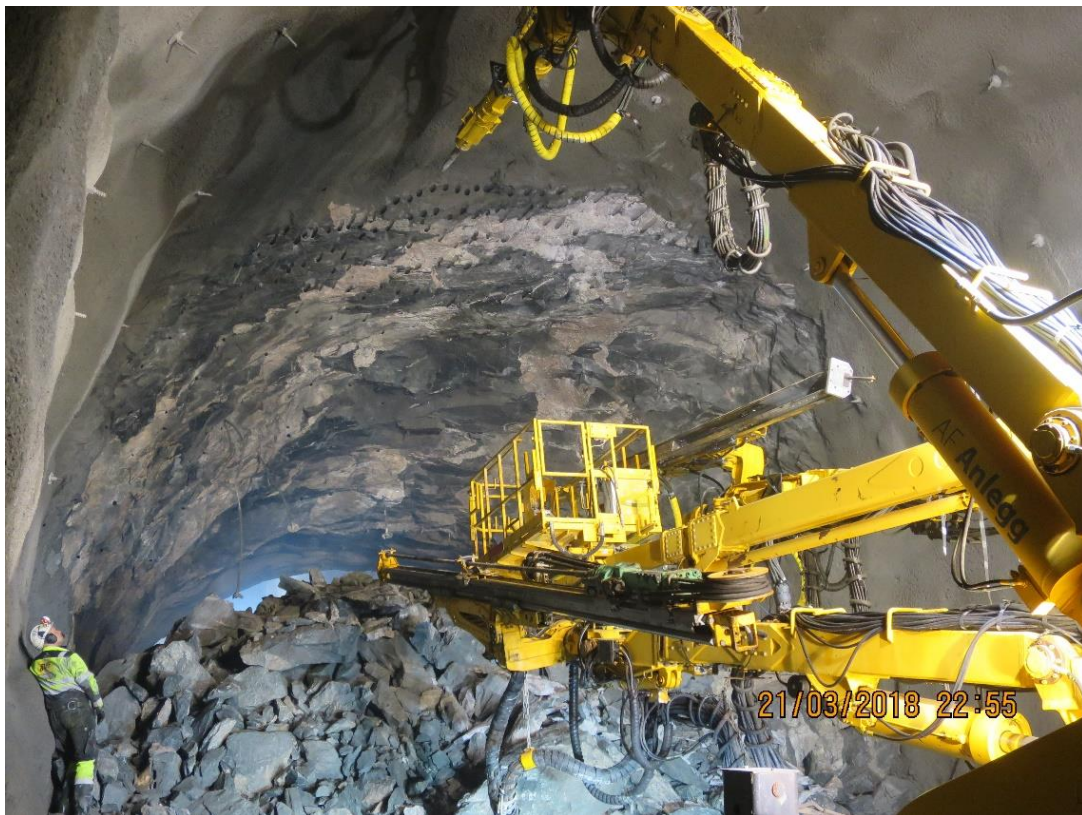
Figur 34 Borerigg med splittere (Foto: Bane NOR).
