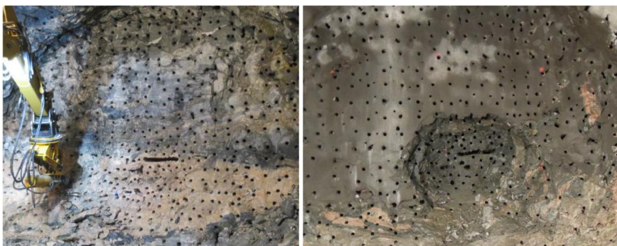
Figur 36 Åpning av kutt med bruk av boret slisse (Jernbaneverket, 2016)
