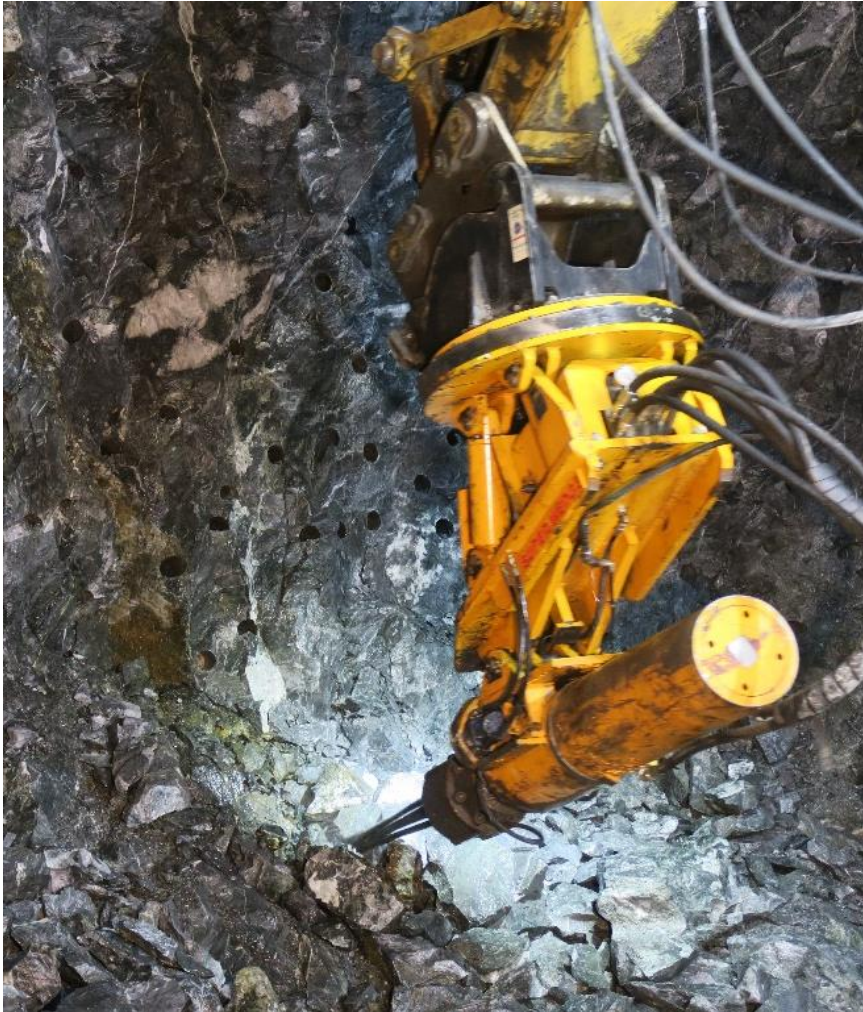
Figur 2 D&S på Follobanen (Foto: T. K. Weydahl, 2017)
