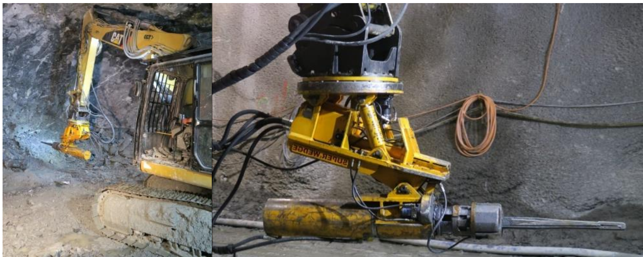
Figur 10 Superwedge montert på graver (Foto T.K. Weydahl, 2017).
