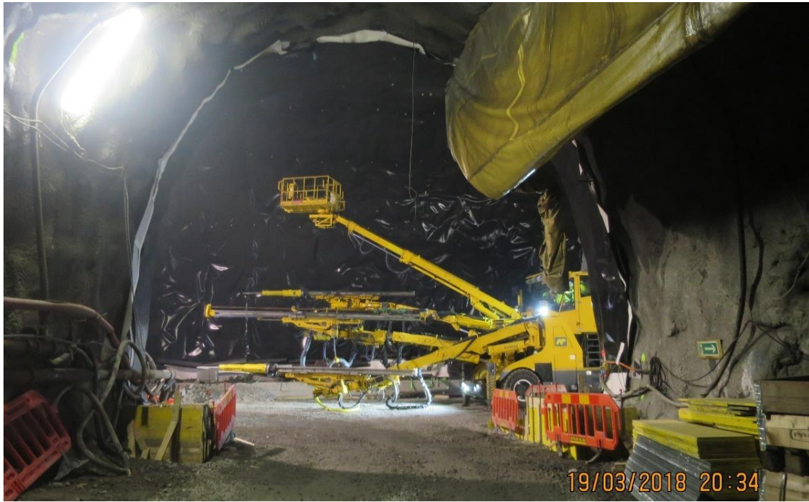
Figur 33 Borerigg med splittere (Foto: Bane NOR).
