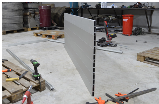
...i tillegg ble det lagt en limfuge mellom profilene
