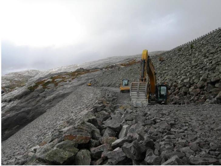
Fig. 1 Reconstruction of the riprap on the downstream slope of Svartevatn dam in south-western Norway. Reconstruction de l'enrochement sur la pente aval du barrage de Svartevatn dans le sud-ouest de la Norvège
