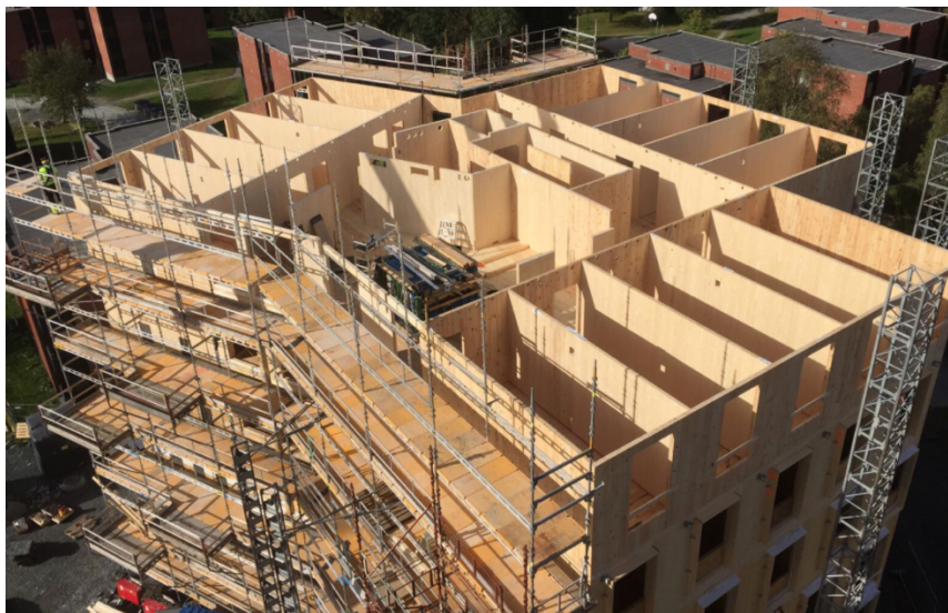
Figur 3 Montering av massivtreelementer på Moholt 50/50 [14]
