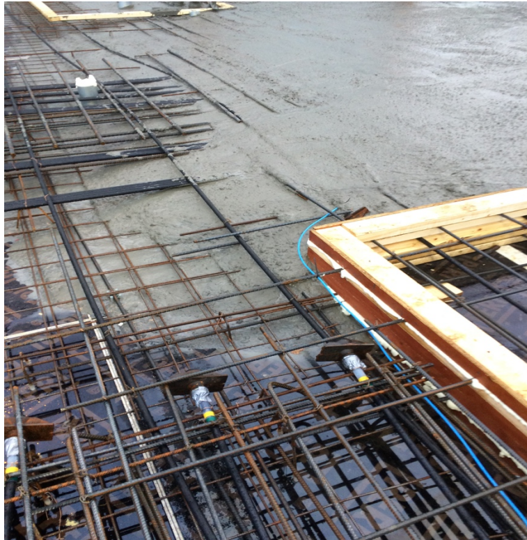
Figur 9 Pågående støp ved Powerhouse Brattørkaia [Foto: Frederic Hermansen]
