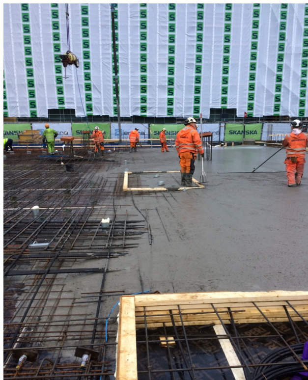
Figur 5 Dekkestøp ved Powerhouse Brattørkaia [Foto: Frederic Hermansen]
