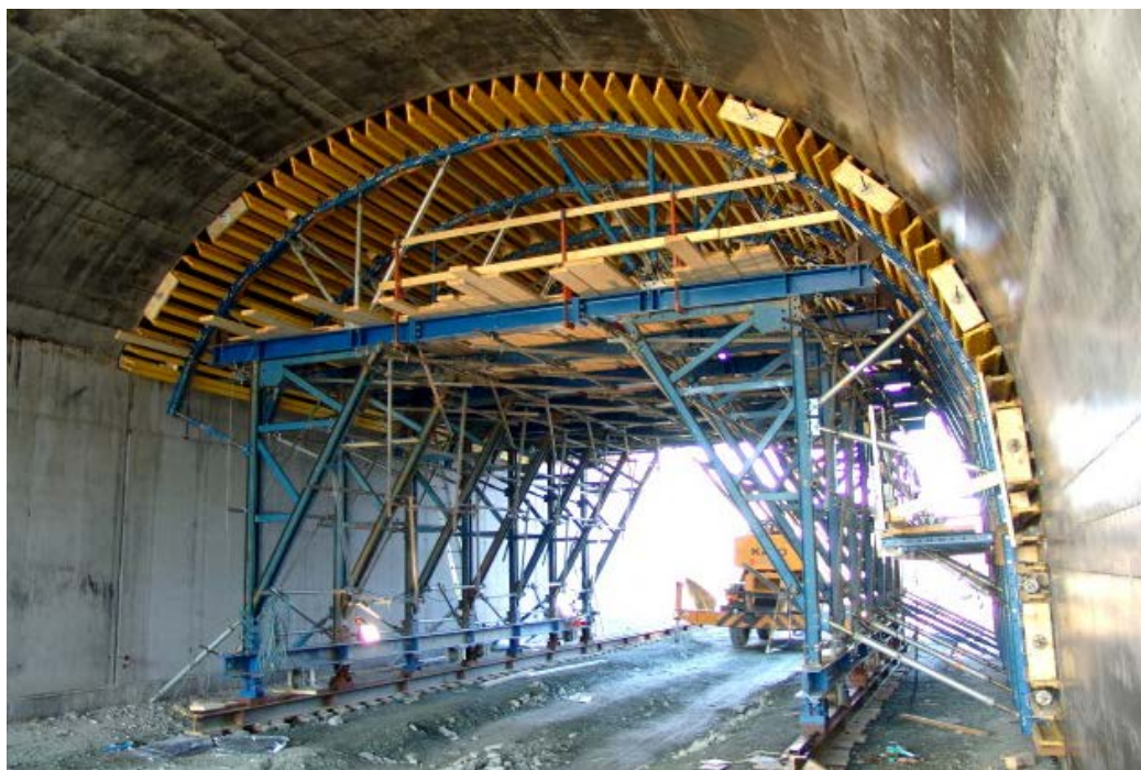
Figur 64 Tunneforsikaling "Doka" , prosjekt Brubakk løsmassetunell på E6 i Melhus [46]
