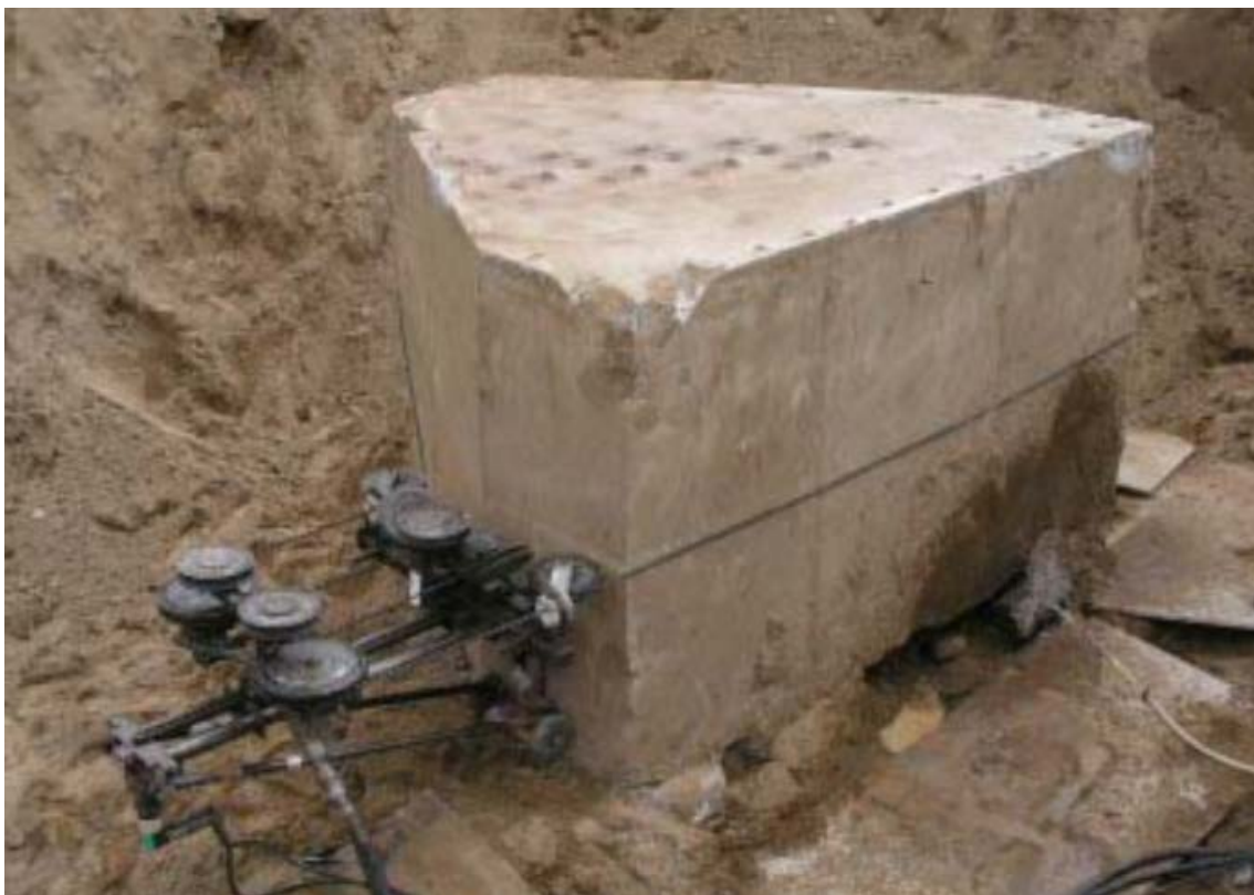
Figur 56 Saging av massive konstruksjoner med wiresag [31]
