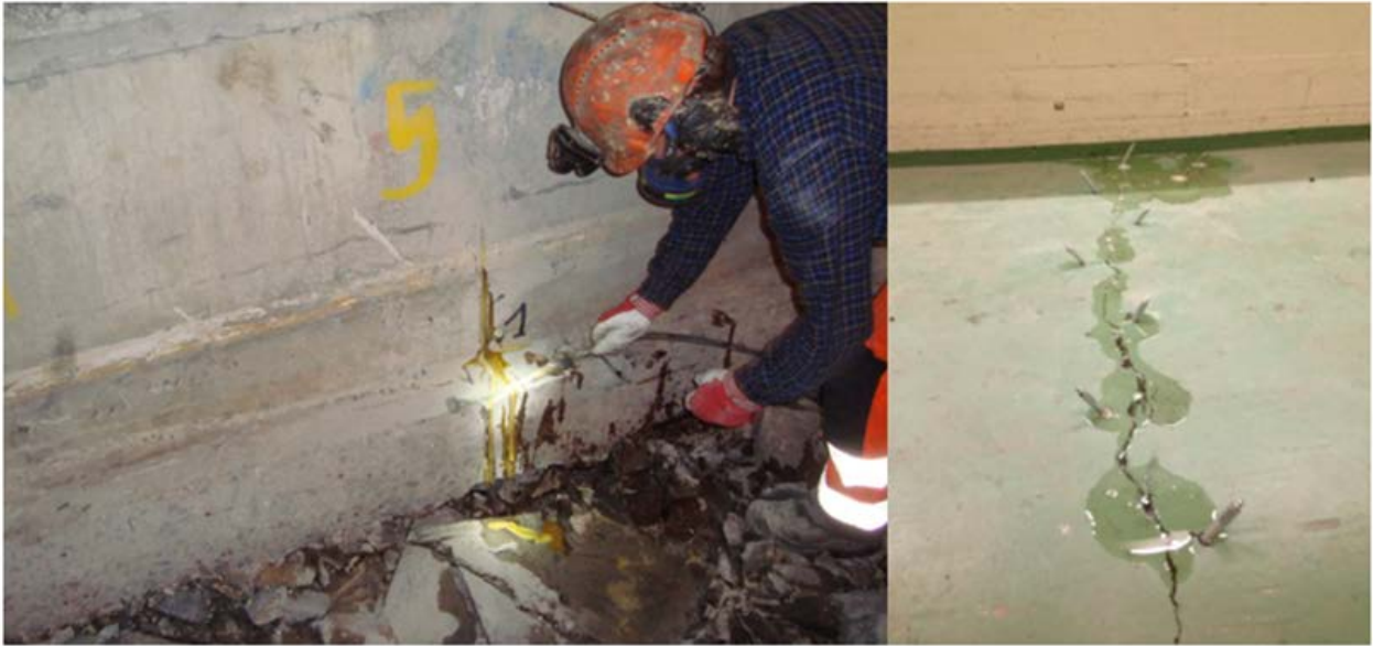
Figur 37 Lekkasjetetting med sementinjeksjon [31]
