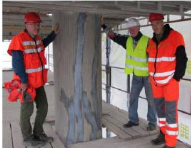
Figur 15 Rehabilitering av Elgeseter bru i Trondheim [45]
