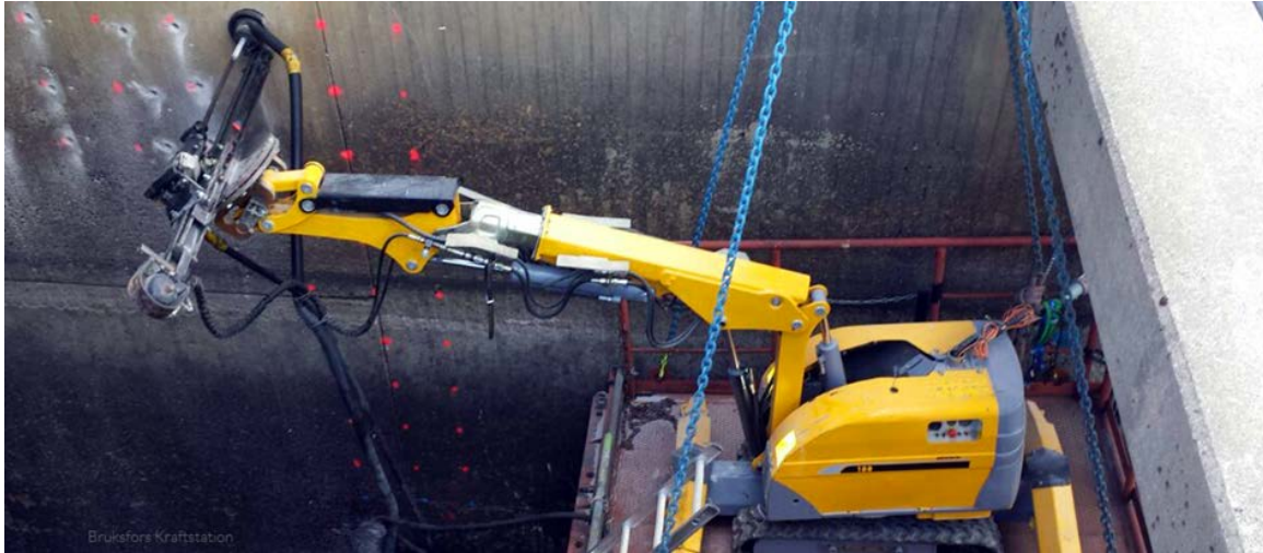
Figur 49 betongboring etter bestemt mønstre ved Bruksfore kraftstasjon [31]
