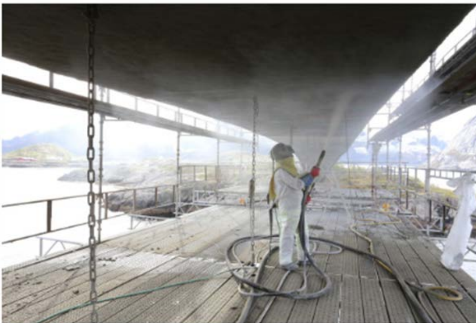
Figur 58 Betongsprøyting på nettingen (Foto: Tomas Rolland)
