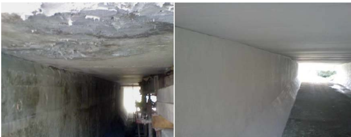
Figur 47 Kulvert før og etter beleggpåføring [34]
