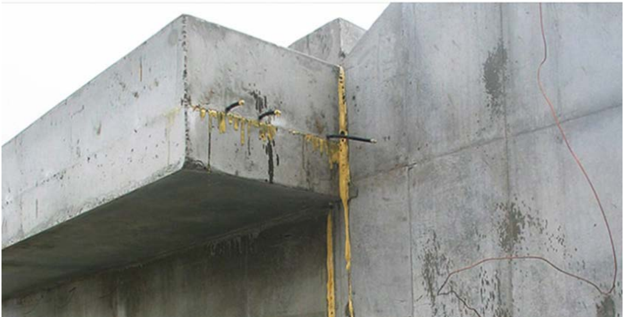
Figur 38 Injisering tatt av AWAB industrigulv www.awabindustrigolv.se
