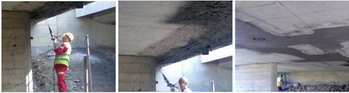
Figur 71 Betongsprøyting og resultat [36]
