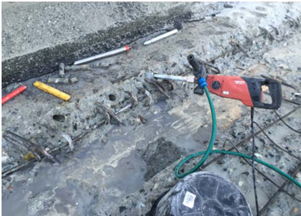
Figur 50 Kjerneboring med håndholdt utstyr på Ladedalenbrua i Trondheim 2015, Perica Benic
