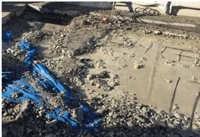
Figur 42 Slamsamling ved vannmeisling på Ladedalen bru i 2015
