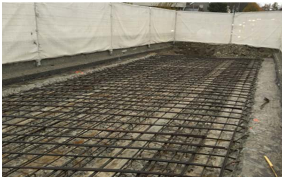
Figur 43 Ferdig vannmeislet, deretter håndmeislet, rengjort og armert på Ladedalen bru i Trondheim i 2015
