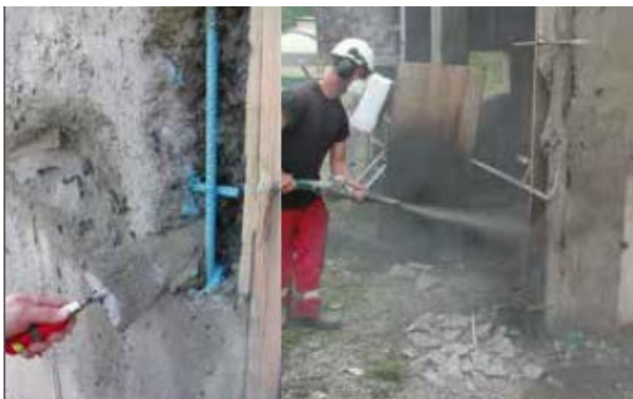
Figur 66 Håndmørtling til venstre og sprøytemørtling til høyre [36]
