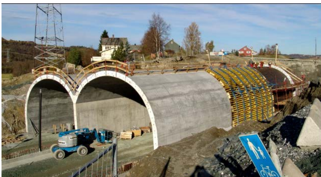
Figur 65 Tunellforsikaling "dobblinga" E6 Melhus [46]
