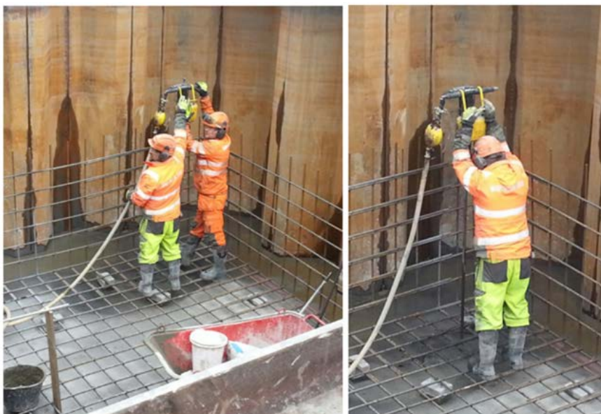
Figur 48 Boring 1,7 meter ned i betong for å gyse armering i brufundamenter. Perica Benic
