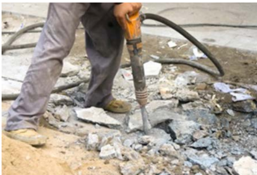
Figur 37 betongmeisling med pneumatiskmeiselmaskin. [47]
