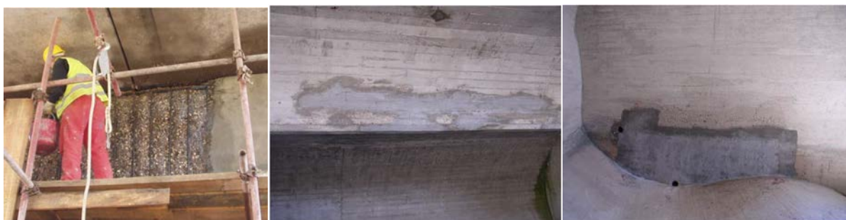
Figur 68 Resultat av håndmørtling
