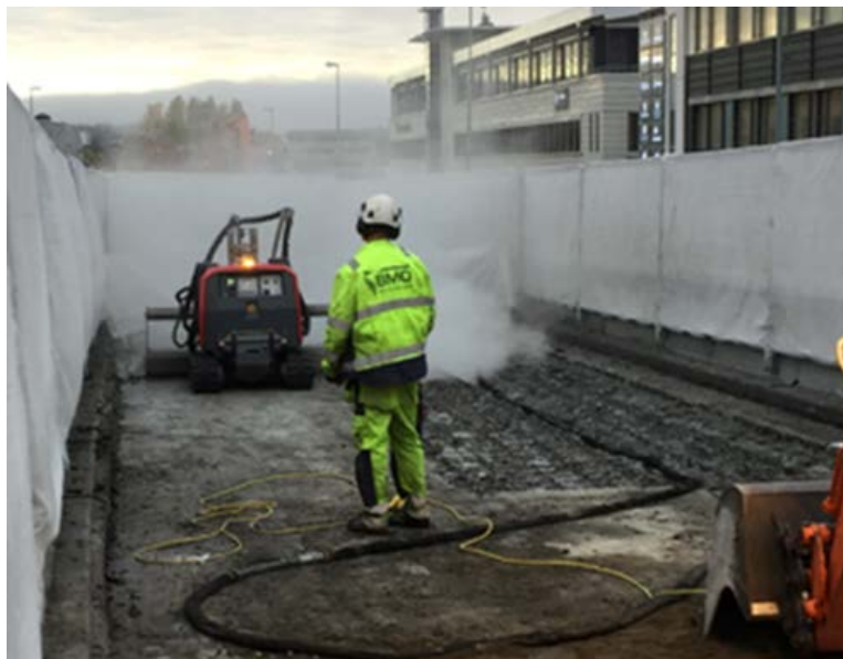
Figur 40 Vannmeisling med robot på Ladedalenbru i Trondheim 2015
