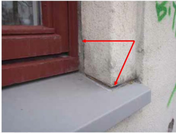
Figur 3.5: Prøvetatt fugemasse på St. Olavs hospital. Figur hentet fra Andersson et al. (2009a) p.7
