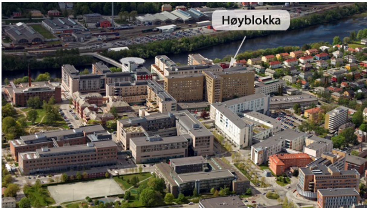
Figur 5.1: St. Olavs Hospital. Høyblokka er den store senepsgule bygningen. Bildet er hentet fra http://www.rørmerking.no/default.asp?Cat=2
