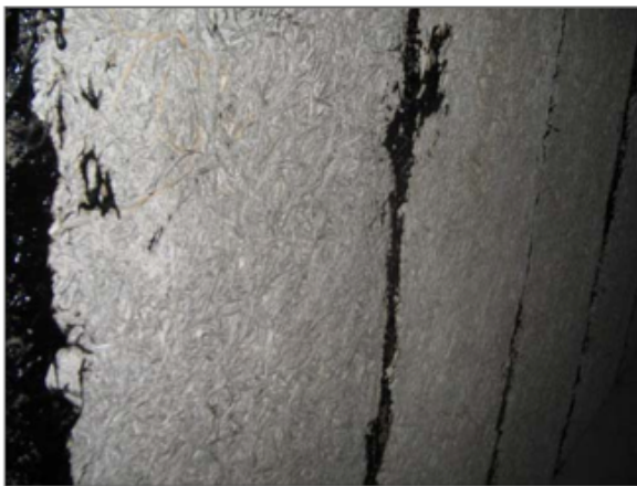
Figur 4.7: Lim mellom treullsementplater. Hentet fra (Amlo og Bakke, 2010) p.37
