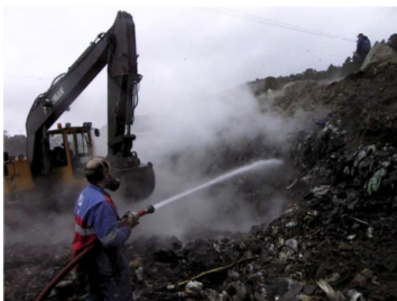
Figur 3.6: Slukking av brann på fyllplass. Bildet er hentet fra Øygard, Måge, Gjengedal, og Svane 2005
