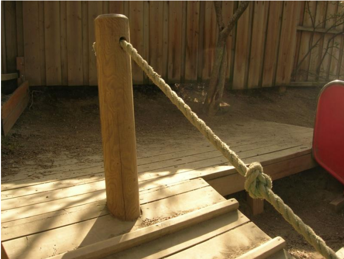
Figur 9.4.1 For ti år siden ble området under plattingen byttet ut, på grunn av arsen forurensning, stolpen som står ned i jorda, er CCA-trykkimpregnert
