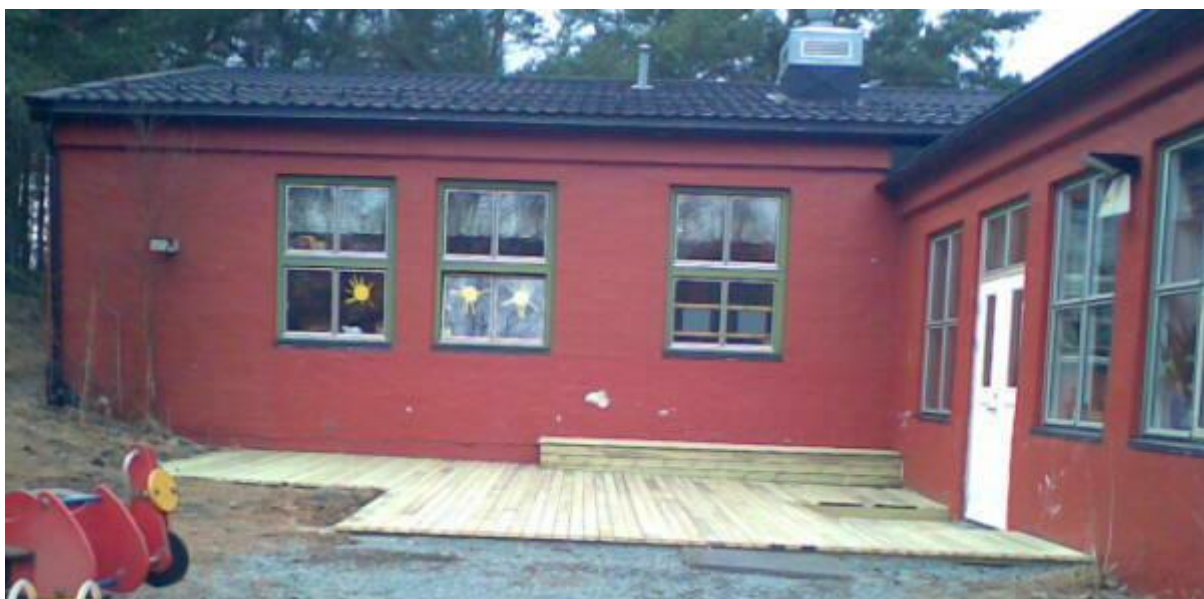
Figur 8.11.2 Ny plattning i Spannet barnehage, den gamle var CCA-trykkimpregnert
