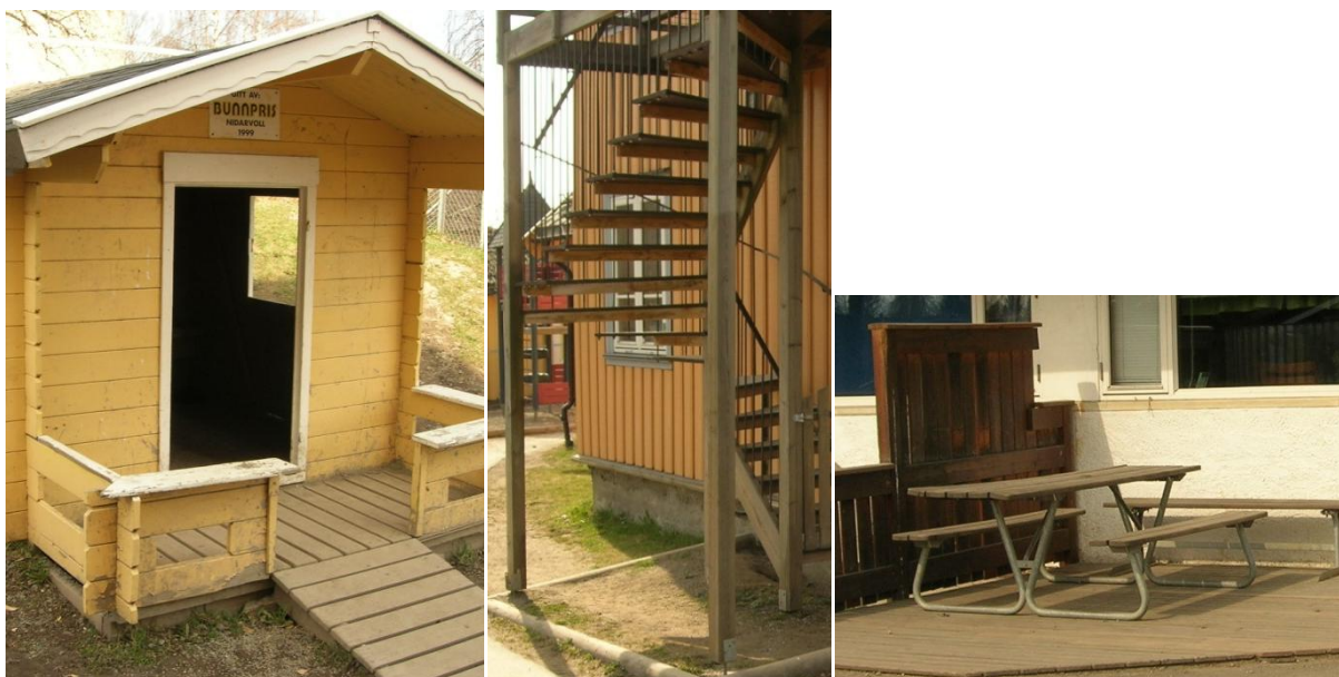
Figur 8.11.16 Plattingen på lekehuset er CCA-trykkimpregnert, det er også denne trappa (i midten) og leveggen og plattformen (til høyre)
