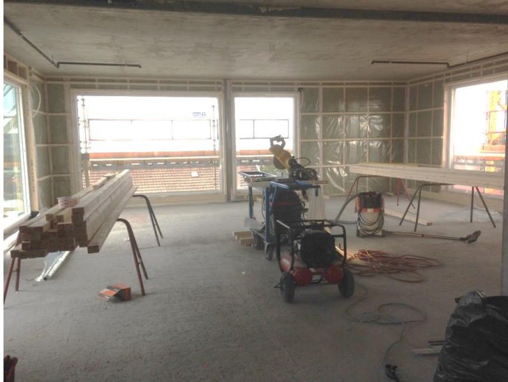
Figur 5: Lokalet i fjerde etasje mot vest ved starten av måleperioden.
