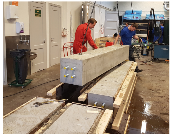
(b) Avforming av prøvestykker 2-3 døgn etter støp.
