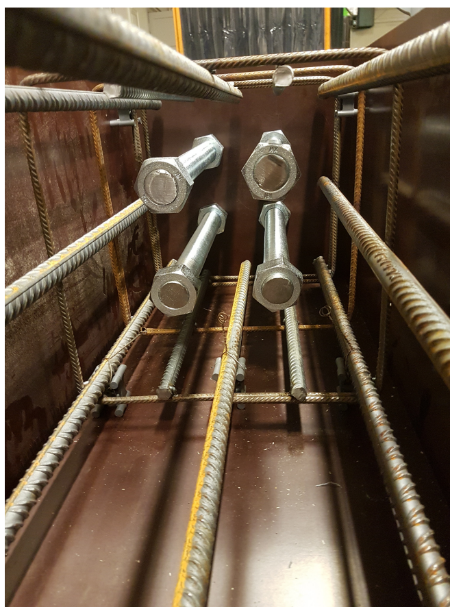
Figur F.4: Innvendig dokumentasjon av armeringskurv i monteringssonen, hvor gjengestengene er klargjort før støpeprosessen.
