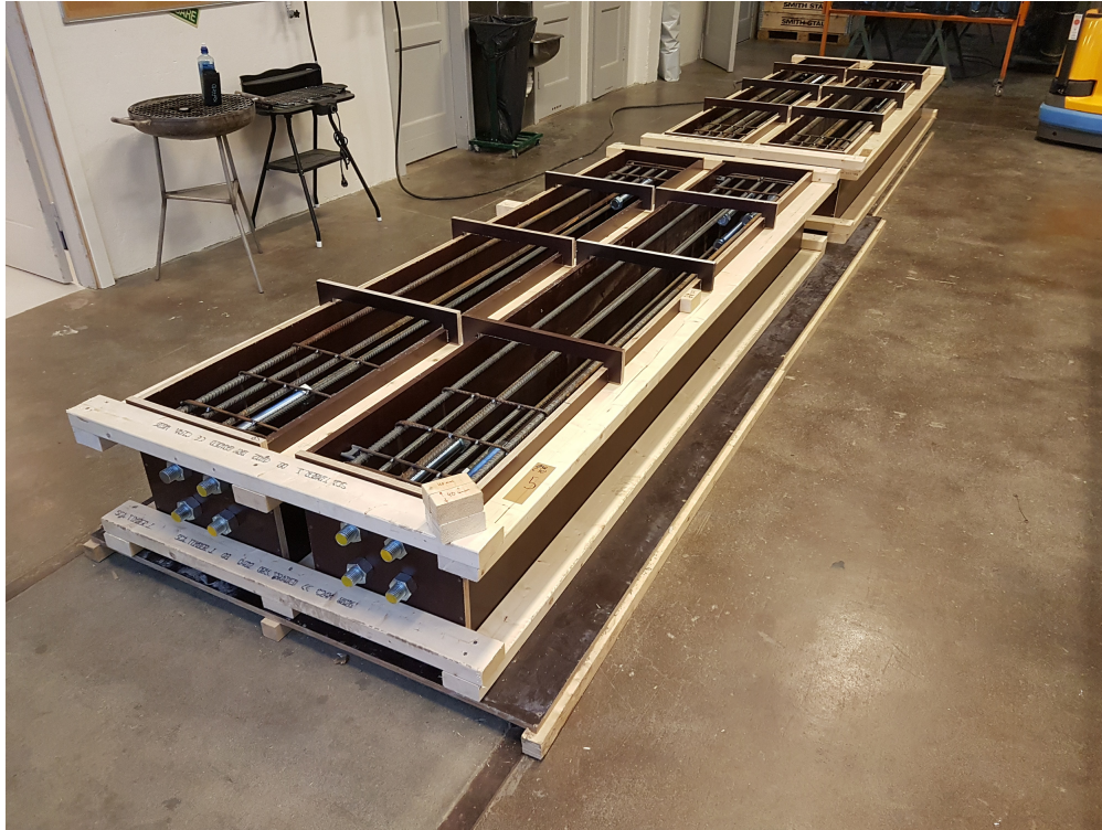
Figur 3.9: Oversiktsbilde for klargjøring av forskaling, avstivet til en felles bunnplate for avstiving med konstruksjonsvirke 2"4. Støping ble gjennomført for fire prøvestykker i to omganger.
