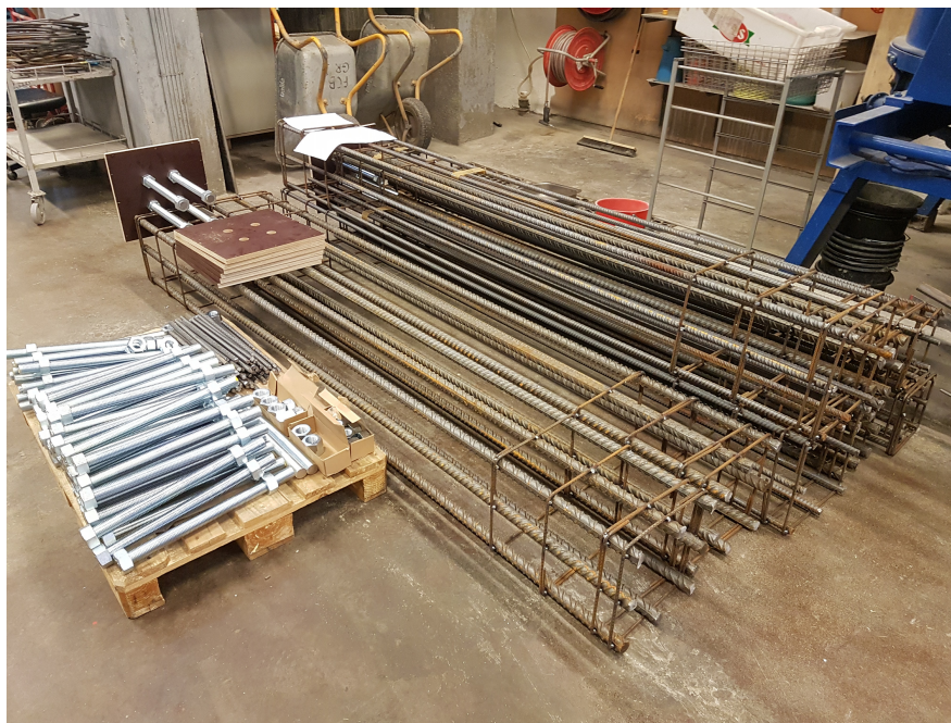
Figur F.2: Materialer klargjort for montering før støpeprosessen: gjengestenger, endeplater og armeringskurver.
