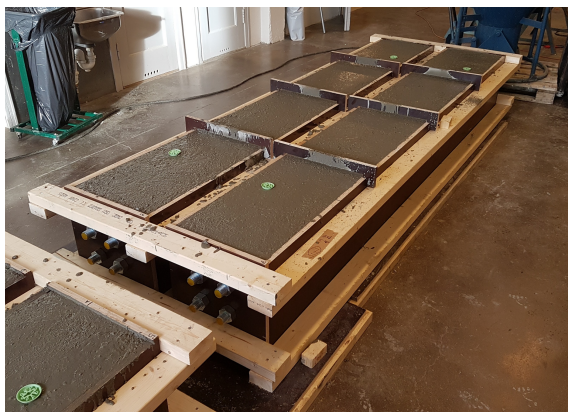
(a) Ferdigstøpt og avrettet betong.
