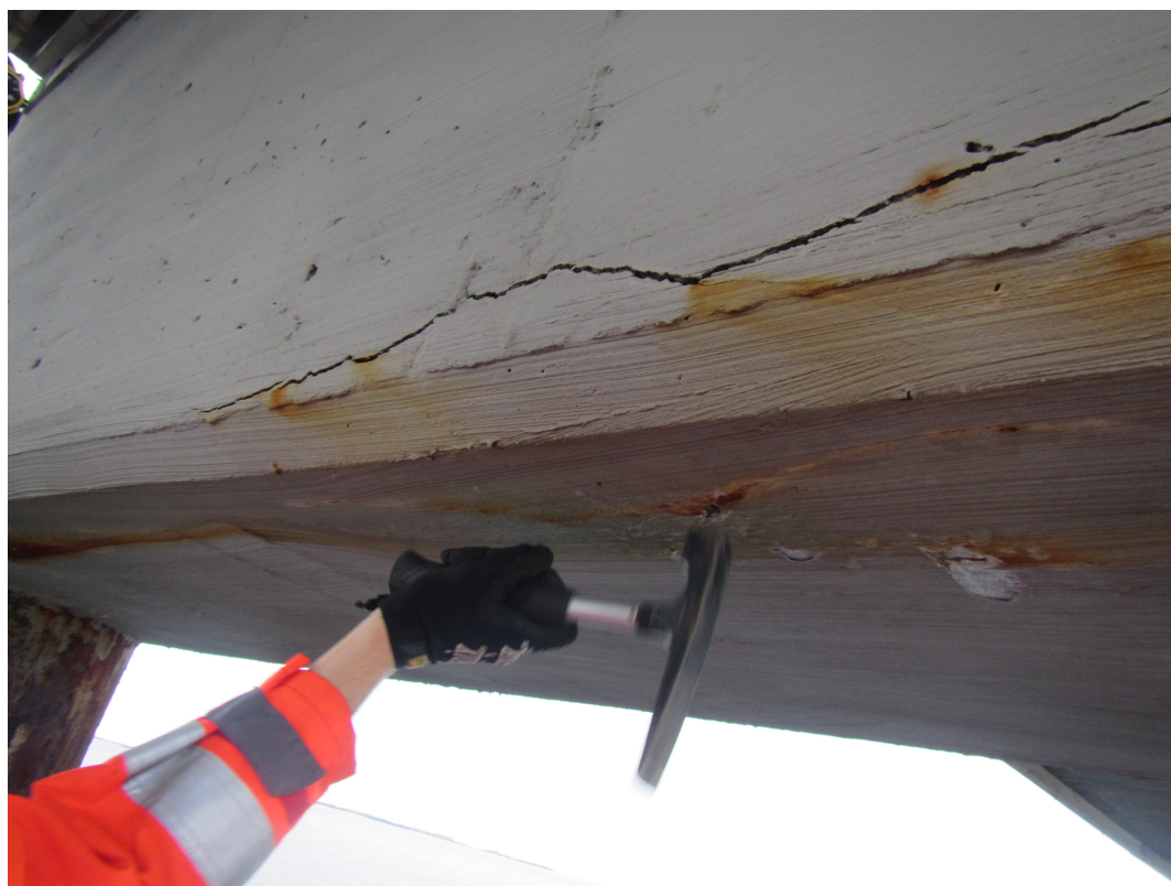
Figur 4.6: Bom på tverrbærer i akse 8.
