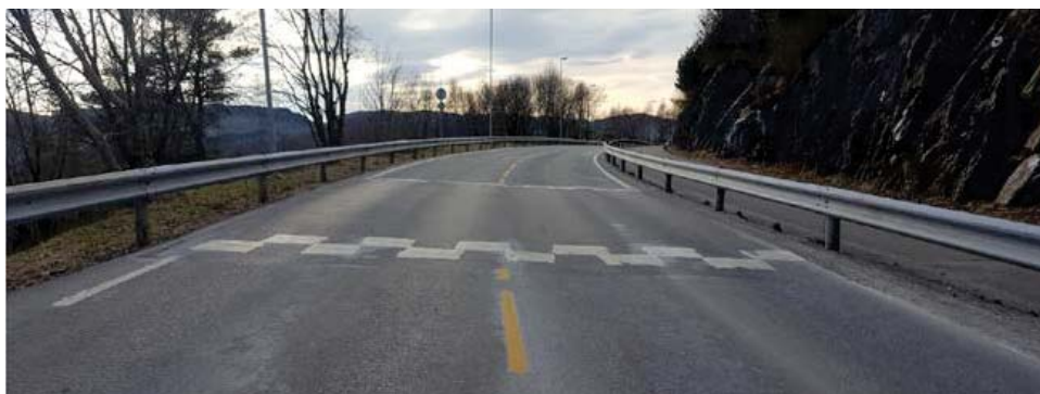
Bilde 9 – Modifisert sirkelhump (Foto: Petter Seim Holten)
