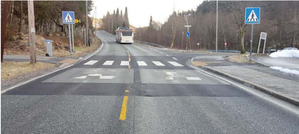
Bilde 26: Oppgavens fartspute dim. 50 km/t (Foto: Petter Seim Holten)
