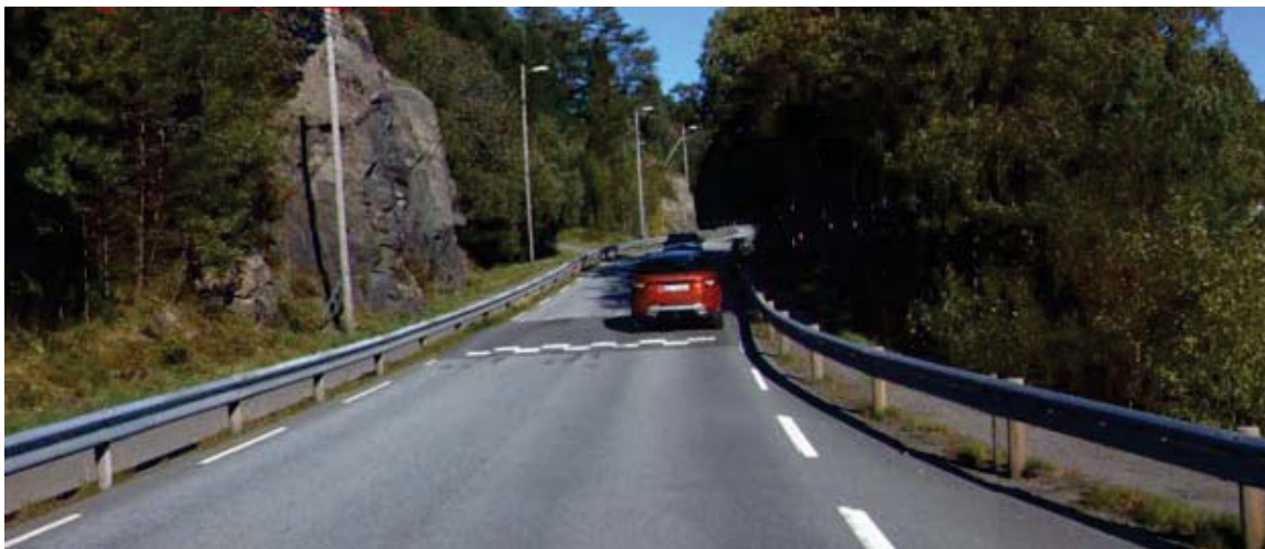
Bilde 30: Oppgavens modifiserte sirkelhump dim. 50 km/t – Ref. hump (Foto: Remy Furevik)
