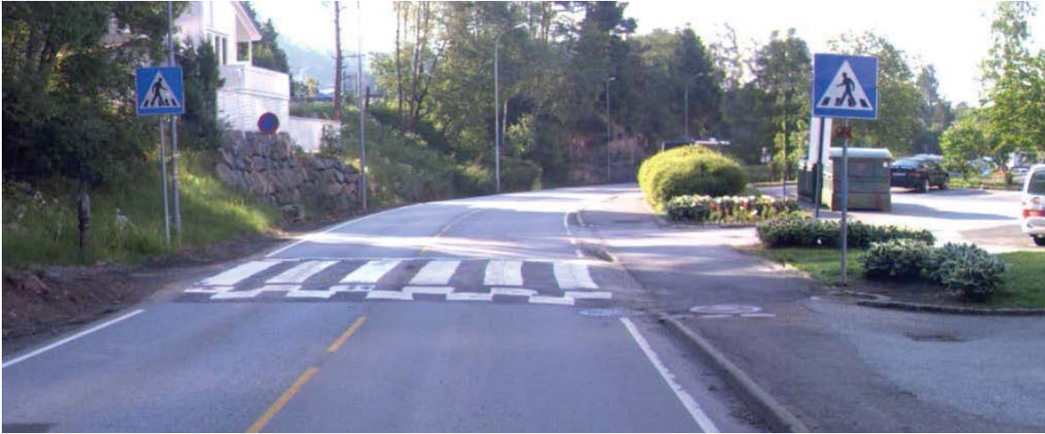
Bilde 18: Oppgavens trapeshump dim. 30 km/t (Foto: Remy Furevik)
