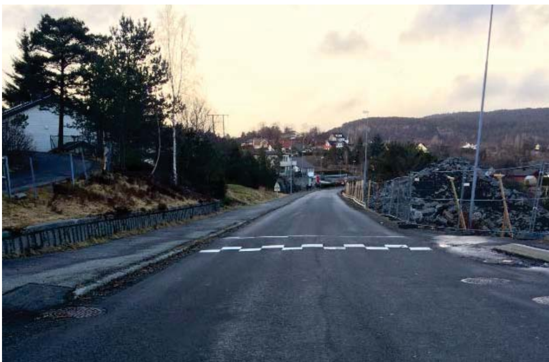
Bilde 12 – Oppgavens modifiserte sirkelhump dim. 30 km/t (Foto: Remy Furevik)
