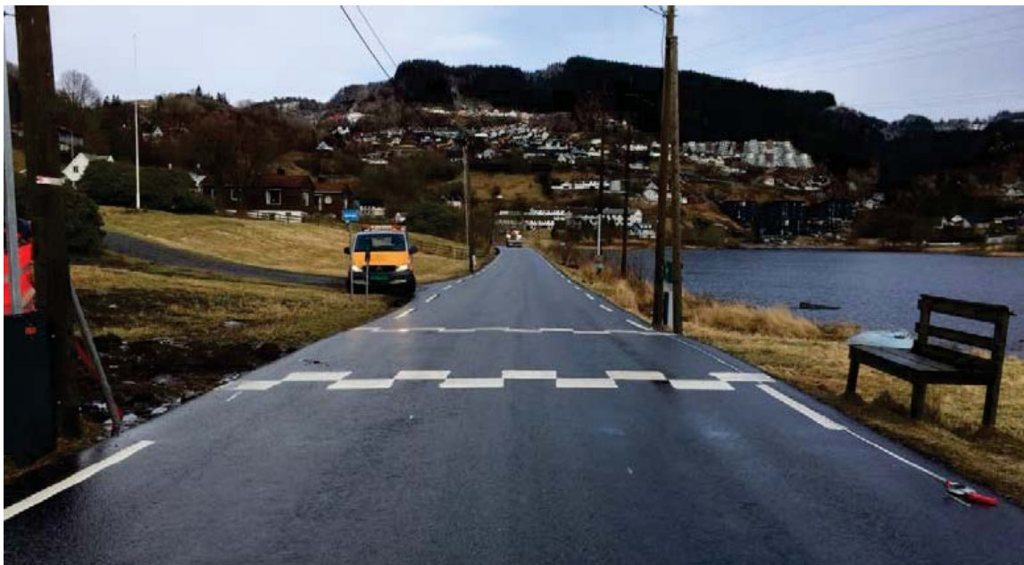
Bilde 32: Oppgavens modifiserte sirkelhump dim. 50 km/t (Foto: Remy Furevik)
