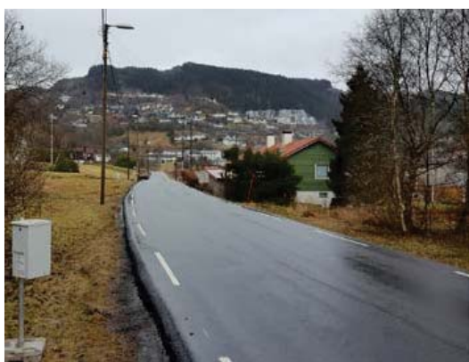
Bilde 4 - Monterte radarapparat
