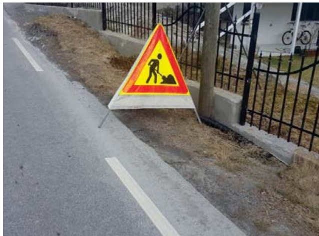
Bilde 6 - Bruk av paraplyskilt - arbeidsvarsling
