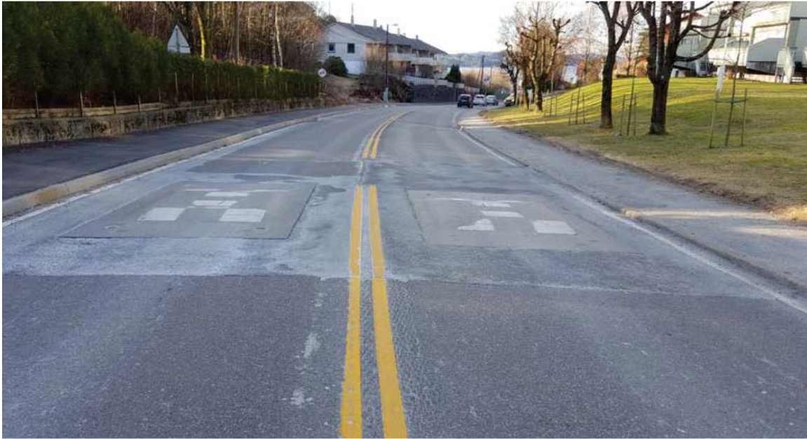
Bilde 24: Oppgavens fartspute dim. 30 km/t (Foto: Petter Seim Holten)
