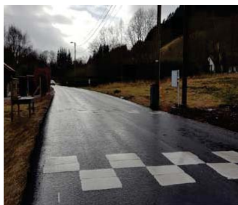
Bilde 5 - Modifisert sirkelhump dimensjonert for 50 km/t
