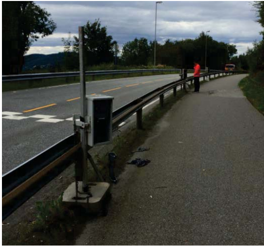
Bilde 2 - Monterte radarapparat
