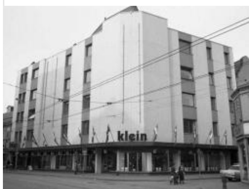
Bilde 21: Kleingården med stålplater på fasaden (Byantikvaren, 1972a)
