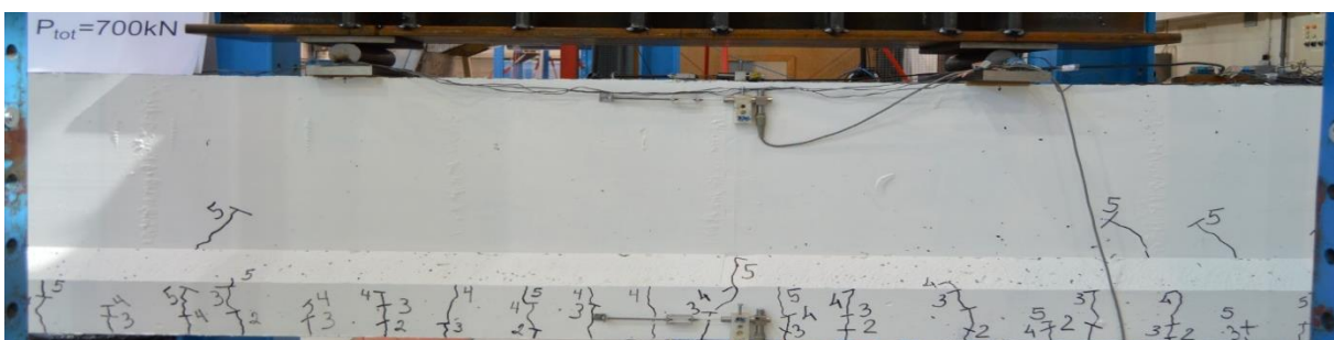
Figur A69: Rissmønster ved 700 kN, momentsone - bjelke 4
