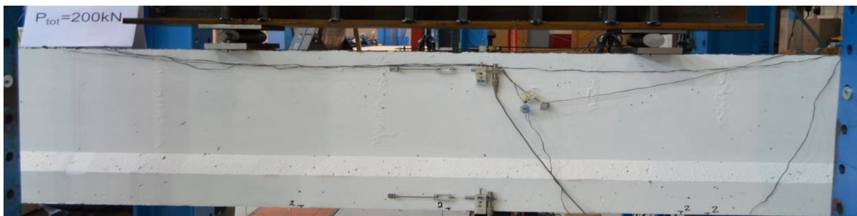
Figur A88: Rissmønster ved 200 kN, momentsone - bjelke 6
