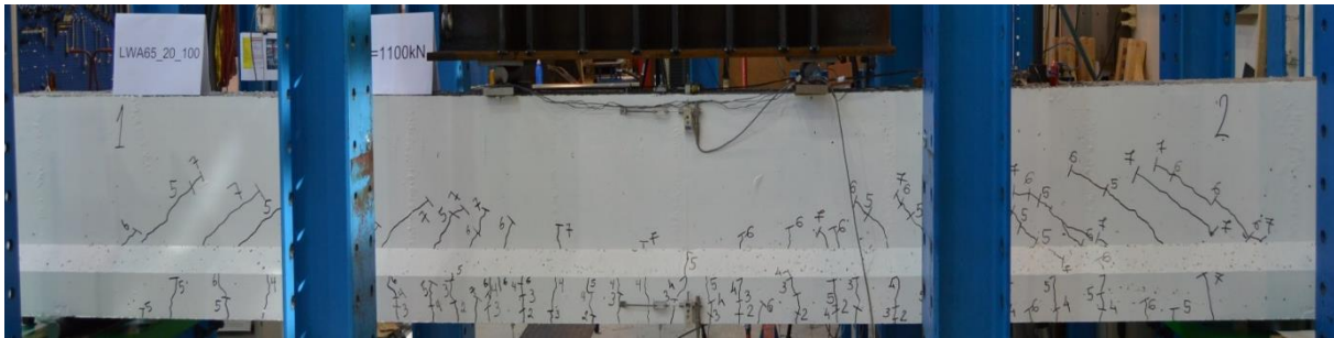
Figur A70: Rissmønster ved 1100 kN, momentsone - bjelke 4
