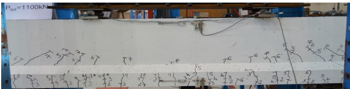
Figur A71: Rissmønster ved 1100 kN, momentsone - bjelke 4
