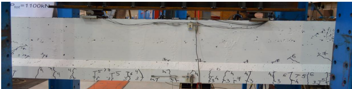
Figur A38: Rissmønster ved 1100 kN, momentsone - bjelke 2
