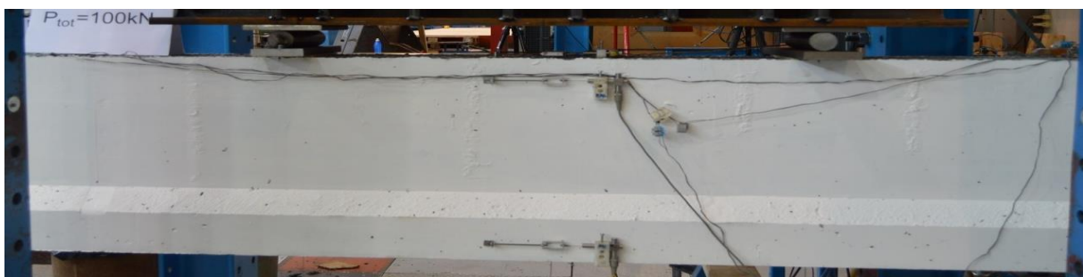
Figur A86: Rissmønster ved 2 \cdot P = 100 kN, momentsone - bjelke 6
