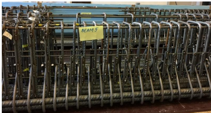
Figur 4.27: Ferdigstillelse av armering for bjelker
