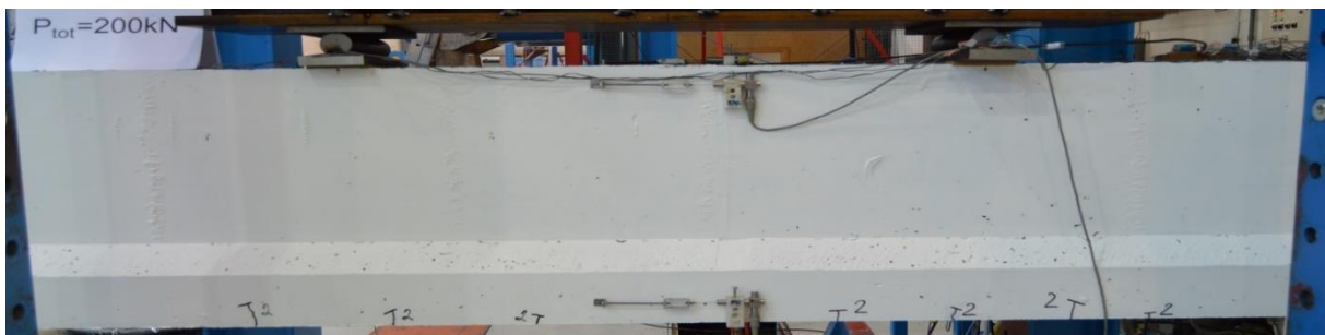
Figur A65: Rissmønster ved 200 kN, momentsone - bjelke 4
