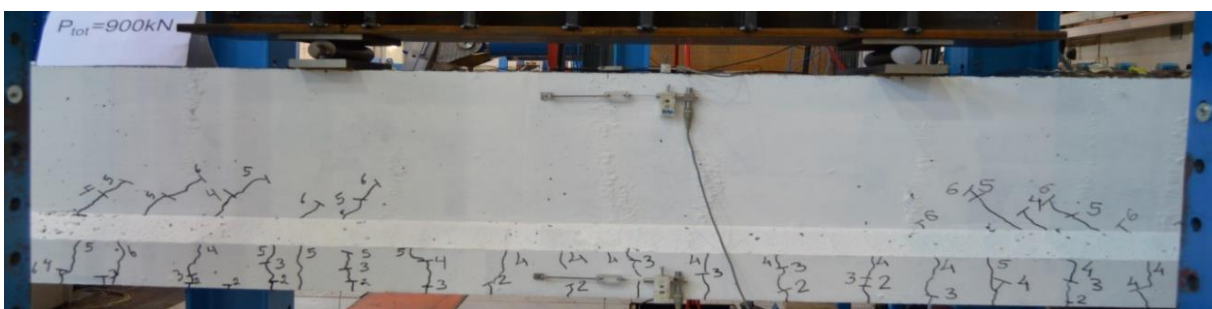
Figur A105: Rissmønster ved 900 kN, momentsone - bjelke 7
