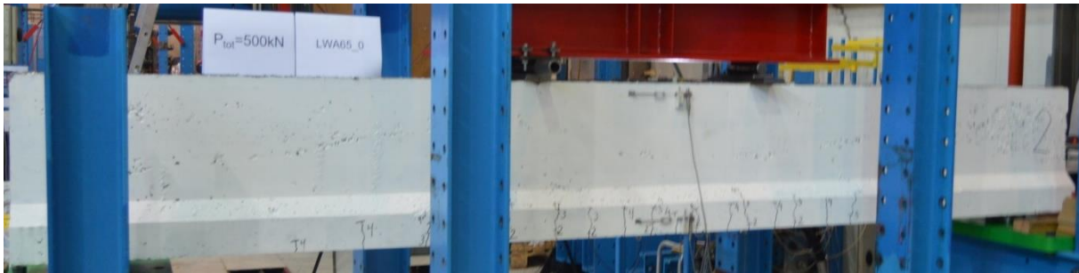
Figur A9: Rissmønster ved 500 kN, bjelke 1
