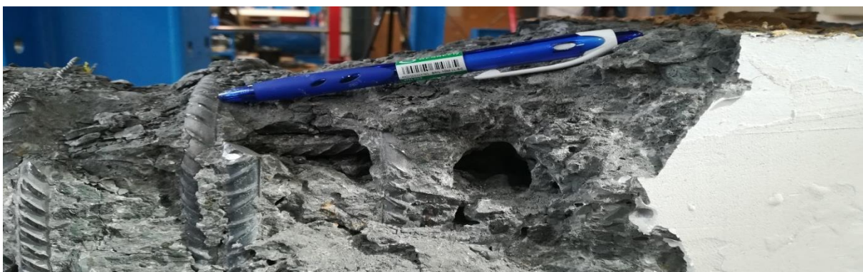
Figur 6.31: Luftrom i betongen, bjelke 5
