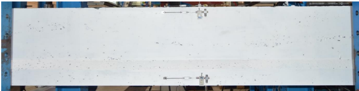
Figur A6: Rissmønster ved 100 kN, momentsone - bjelke 1
