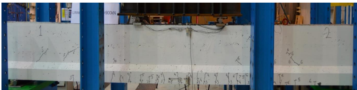
Figur A35: Rissmønster ved 900 kN, bjelke 2
