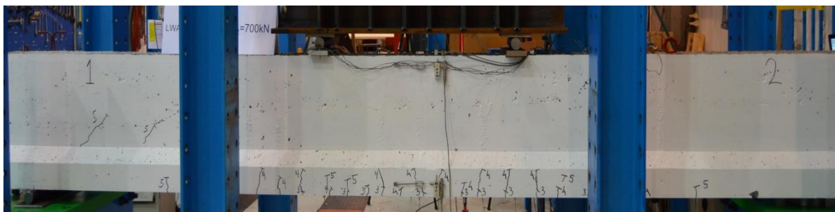
Figur A33: Rissmønster ved 700 kN, bjelke 2
