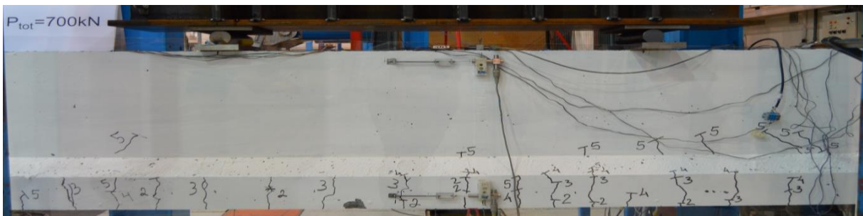
Figur A51: Rissmønster ved 700 kN, momentsone-bjelke 3
