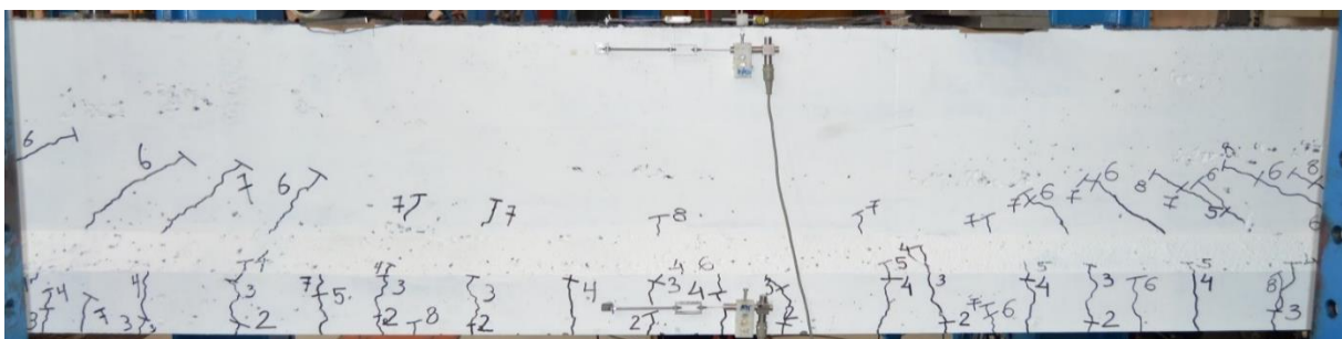
Figur A16: Rissmønster ved 1200 kN, momentsone - bjelke 1
