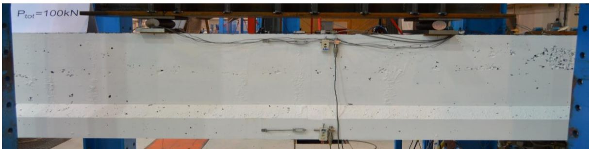
Figur A30: Rissmønster ved 100 kN, momentsone - bjelke 2
