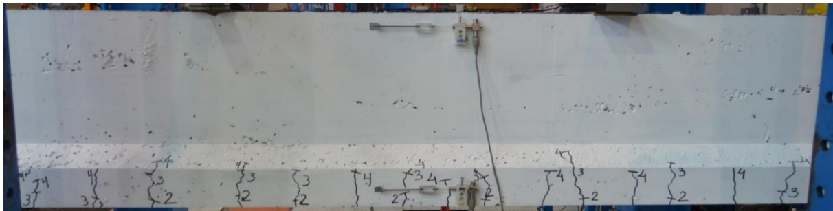
Figur A10: Rissmønster ved 500 kN, momentsone - bjelke 1
