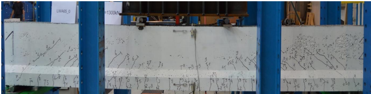
Figur A17: Rissmønster ved 1300 kN, bjelke 1
