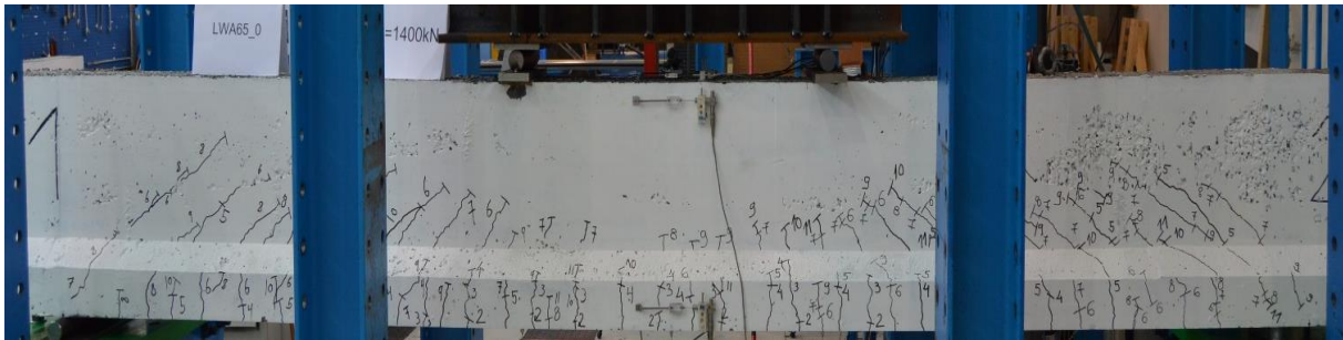
Figur A21: Rissmønster ved 1400 kN, bjelke 1
