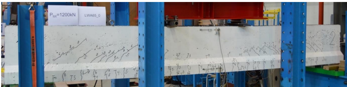
Figur A15: Rissmønster ved 1200 kN, bjelke 1
