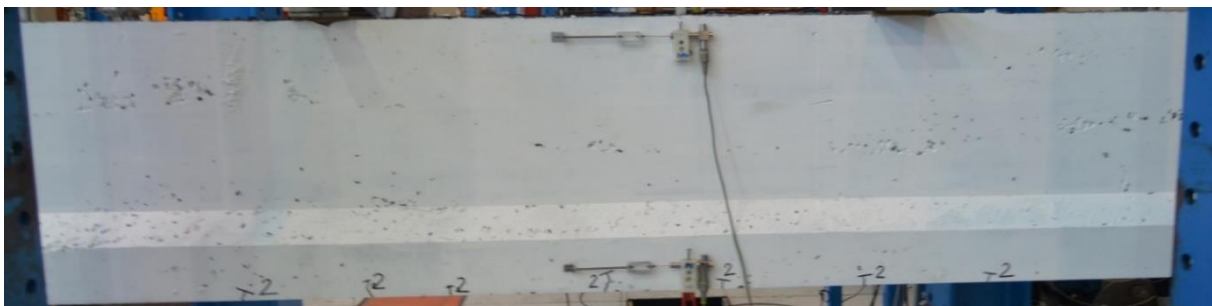
Figur A8: Rissmønster ved kN, momentsone - bjelke 1
