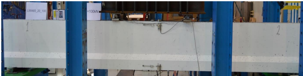
Figur A62: Rissmønster ved 100 kN, bjelke 4
