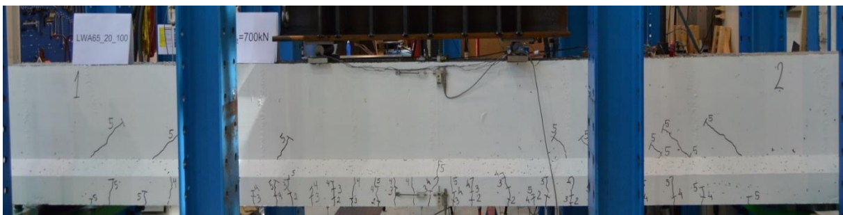
Figur A68: Rissmønster ved 700 kN, bjelke 4
