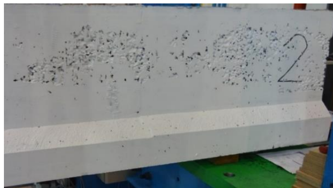
Figur 6.2: Ujevnheter på betongoverflaten, bjelke 1
