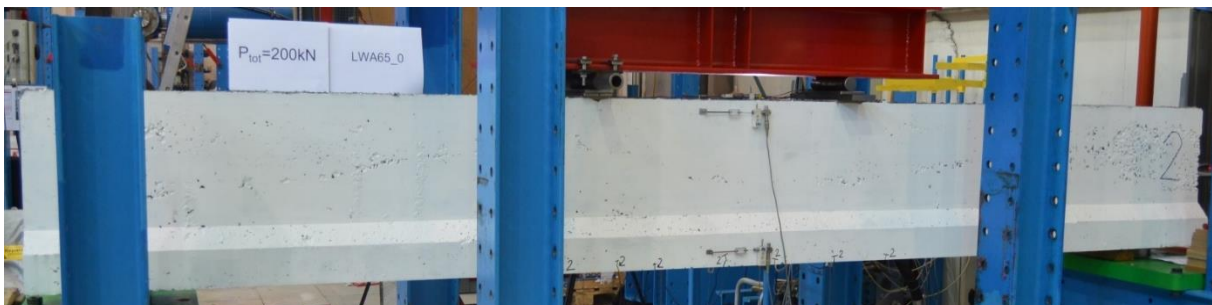
Figur A7: Rissmønster ved 200 kN, bjelke 1
