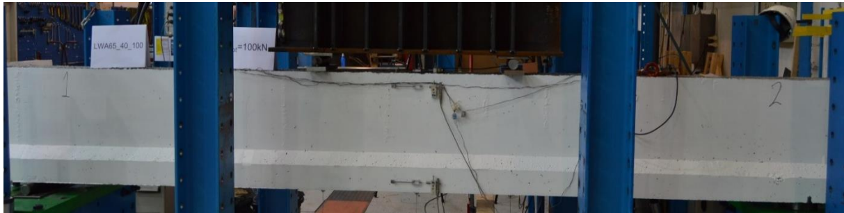
Figur A85: Rissmønster ved 100 kN, bjelke 6
