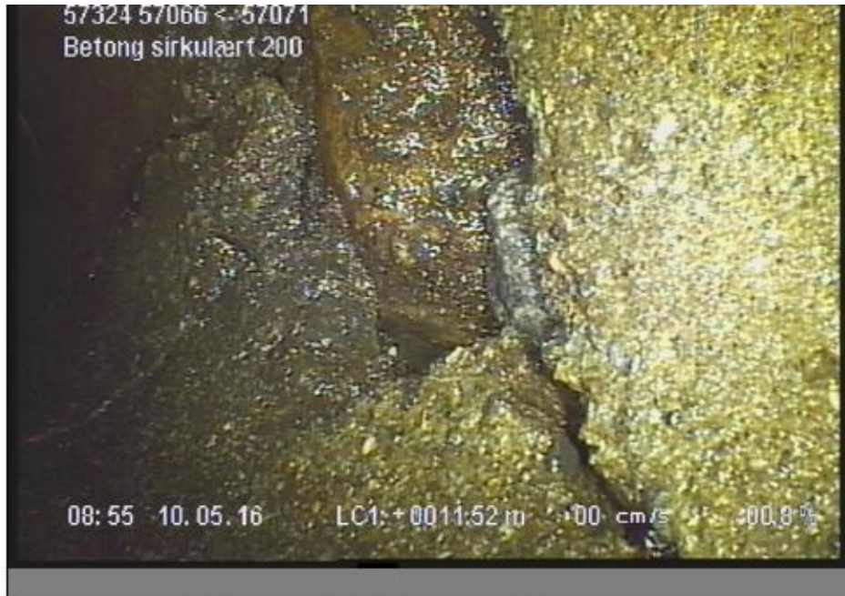
Foto: 2_1_4_10052016_094316_A.JPG, 00:01:48 11,5m, Sprukket rør, Rørbiter har løsnet eller mangler/teglstein mangler fra sin opprinnlige posisjon, fra 12 til 12 Kl., Kompleks
