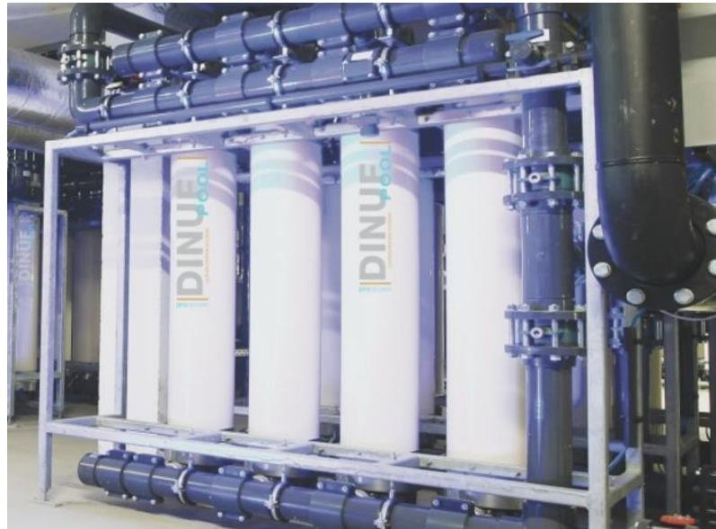
Figur 20. DINUF ultrafiltreringsanlegg fra Sverige
