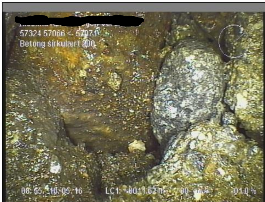
Foto: 2_1_4_10052016_094316_A.JPG, 00:01:48 11,5m, Sprukket rør, Rørbiter har løsnet eller mangler/teglstein mangler fra sin opprinnlige posisjon, fra 12 til 12 Kl., Kompleks
