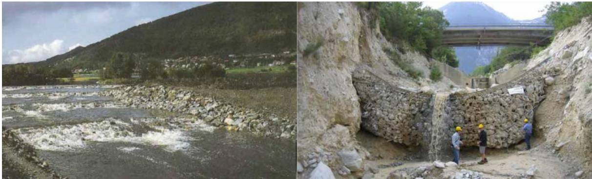
Figur 2.23: Terskler i en elv i Møre og Romsdal (venstre), og et eksempel på en kontrolldam (høyre) (Norem og Sandersen, 2014).
