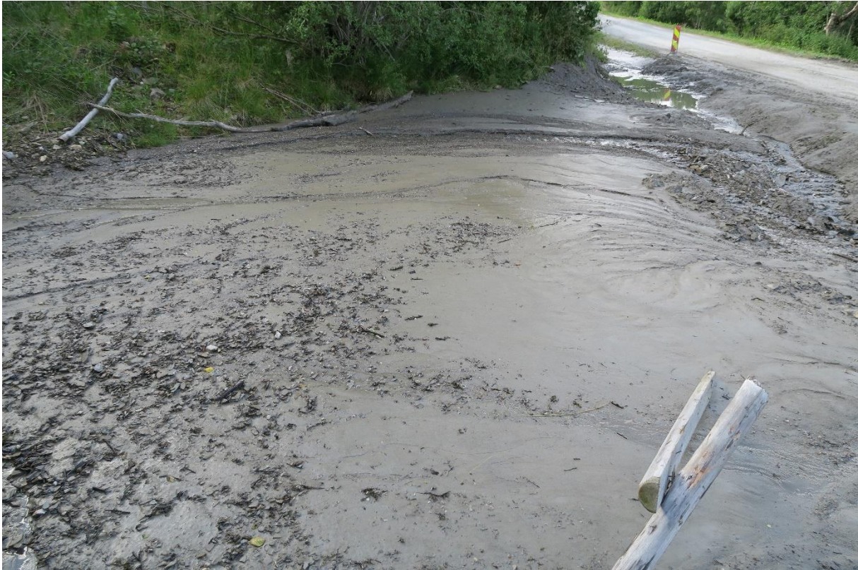
Figur 5.14: Avsetning flomskred med stort innhold av finstoff. (Foto: Knut Ivar Lindland Tveit, 02.08.16)
