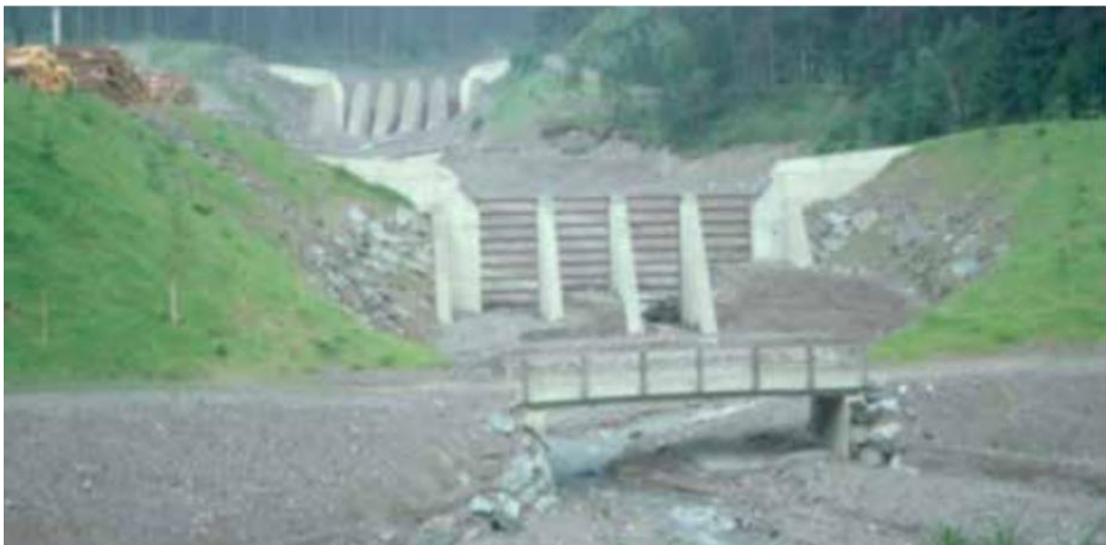
Figur 2.25: Eksempel på åpen kontrolldam (Norem og Sandersen, 2014).
