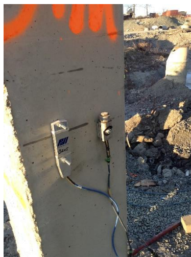
Figur 3.2 PDA-utstyrt påmontert pel
