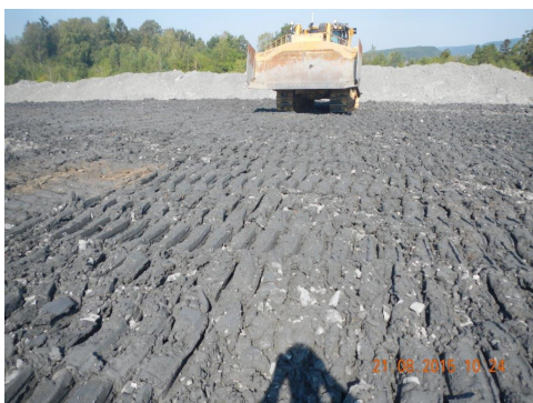
(a) Testfelt for bruk av kalk-/sementleire
