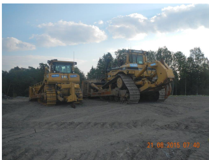
Figur 3.7: Cat D11 (venstre) og Cat D8 (høyre) benyttet i utlegging ved Langøya (Foto: Harald Hansen, NOAH)
