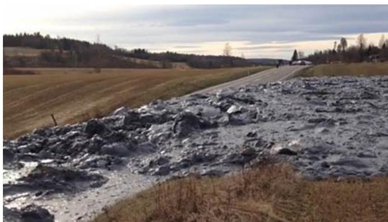
Figur 1.2: Utglidning av massedeponi i Hobøl (Askim, 2014)
