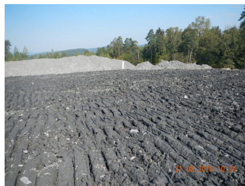
(b) Orientering av beltespor for avrenning. Bildet lyver om terrenghelningen.
