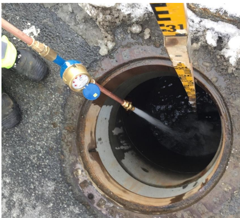
Figur 23 Viser påfylling av vann i infiltrasjonskummen under forsøk.
