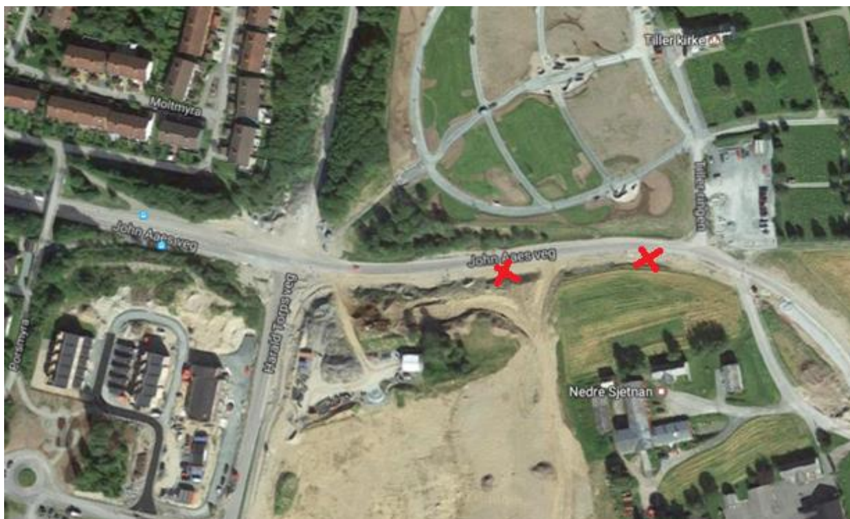
Figur 13 Flyfoto som viser området og vegen hvor kummene er anlagt (Finn.no, 2017). De røde kryssene illustrerer kummenes plassering.
