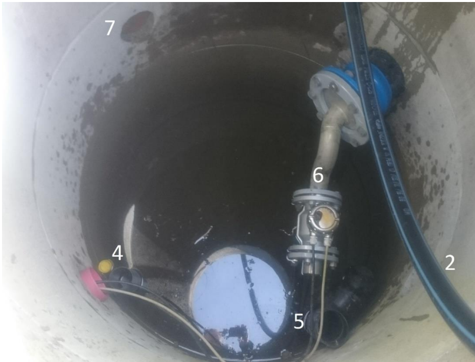
Figur 27 Infiltrasjonskummen det utføres forsøk på, kummen elementer er nummerert.
