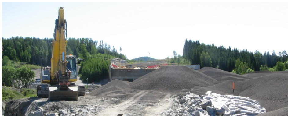
Figur 3.13 Lettklinkerfylling, Krosby-Knapstad (foto. Jon Hauge)
