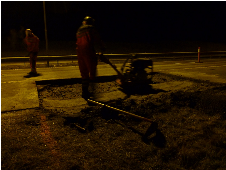
Figur 3.25 Reparasjon av prøvehullene
