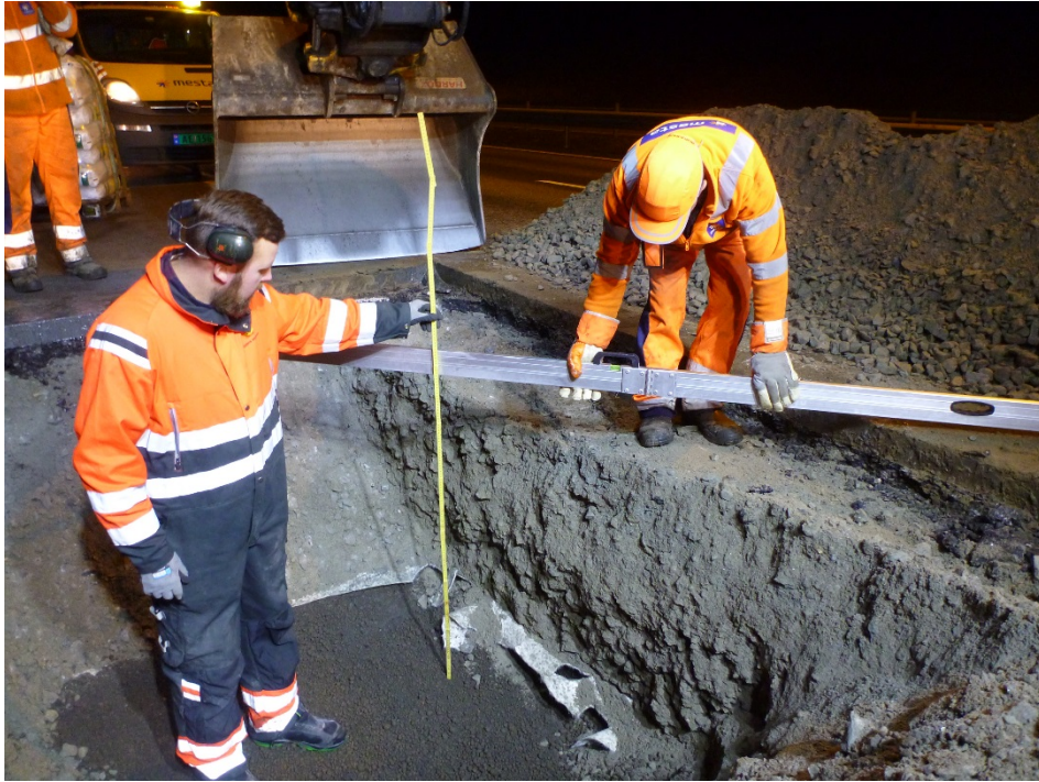
Figur 3.20 Oppmåling av dybde ned til lettfyllingen
