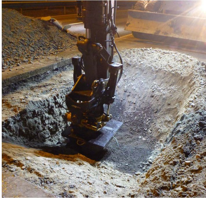
Figur 3.22 Nedtrykking av prøvetaker med gravemaskin, jevnt og rett ned.
