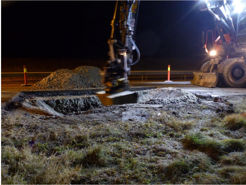
Figur 3.18 Utgraving av bærelaget
