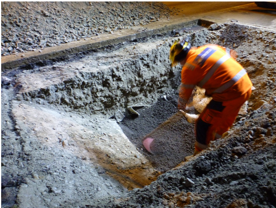
Figur 3.19 Fjerning av fiberduk og fjerning av de ti øverste cm av den lette fyllmassen slik at den direkte nedknusningen fra komprimeringen av fyllingen ikke skulle påvirke resultatene
