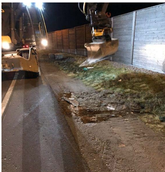
Figur 3.14 Hull 1 i banketten, Borgekrysset (foto: Per Olav Sollien)
