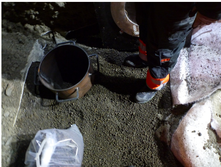
Figur 3.10 Lettklinker hull 3, Jarle bru
