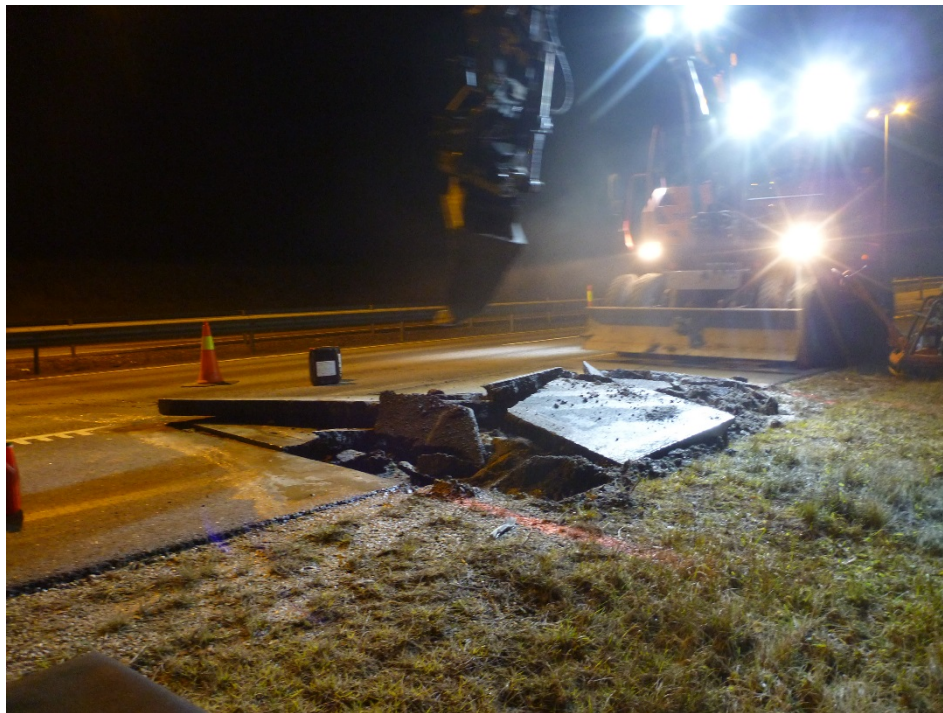
Figur 3.17 Saging og fjerning av asfaltdekket
