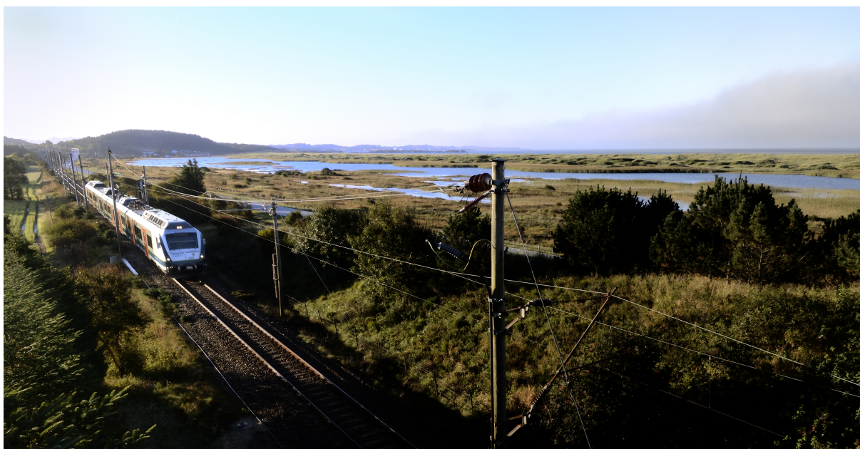
Figur 1.13: Tremaster på strekket fra Brusand mot Oгна langs Jærbanen. Foto: Øystein Grue.
