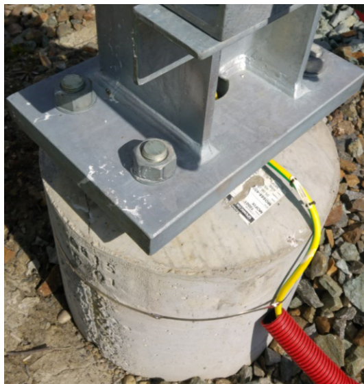
Figur 5.4: HE240B-mast i Klettbakkene.
