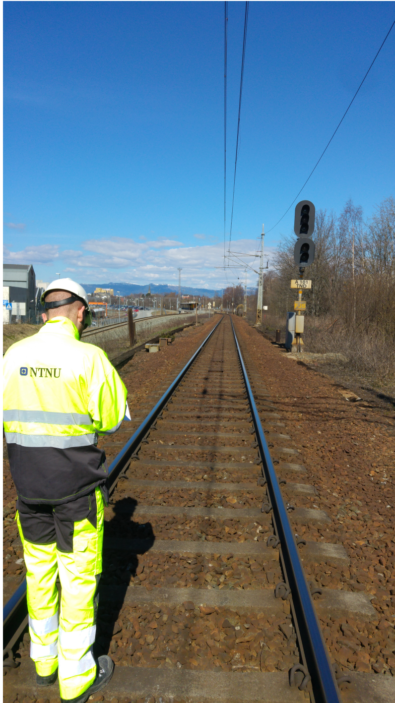
Figur 3.2: Forbigangsledning ved Marienborg stasjon, Trondheim.
