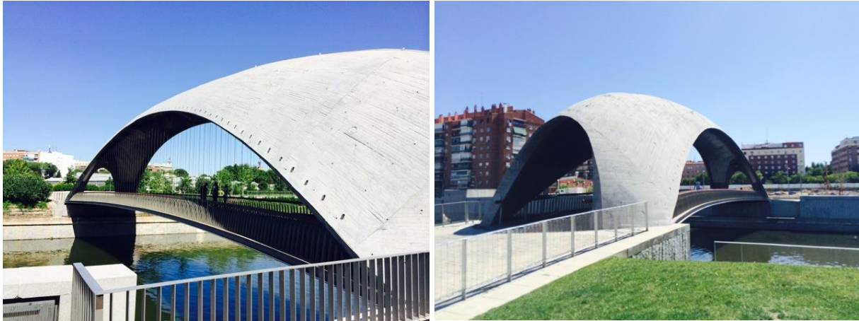
Figur 3.4. Cascara Bridge med beliggenhet i Madrid, Spania (Moore, 2015).
