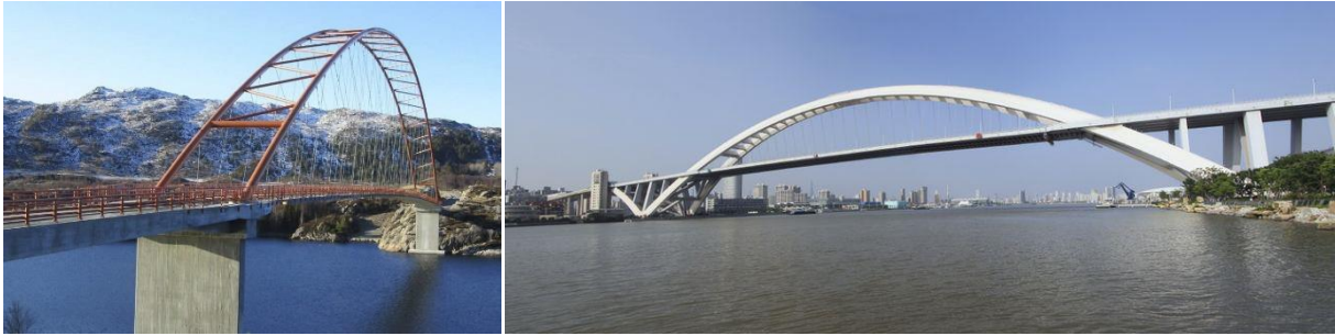
Figur 1.15. Høyre: Brandangersundbroen: through-arch-bro (Firda, u.å.). Høyre: The Lupu Bridge: half-through-bro (Rockburne, 2013)
