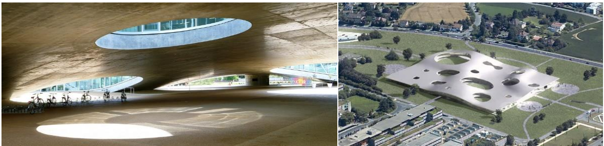
Figur 3.2. Rolex Learning Center. Venstre: Innside betongskall (SANAA, u.å). Høyre: Oversiktsbilde (Azémam, 2010).
