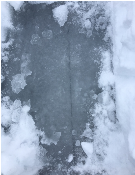
(a) Vannfylt sprekk nær søndre side av magasinet
