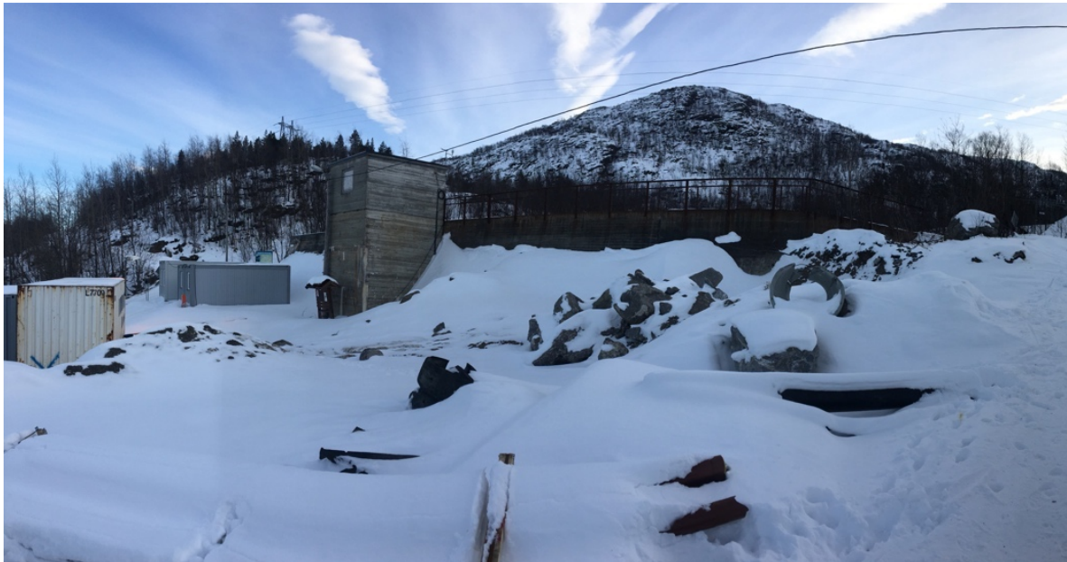
Figur 1.4 Panoramabilde av dam Taraldsvikfossen
