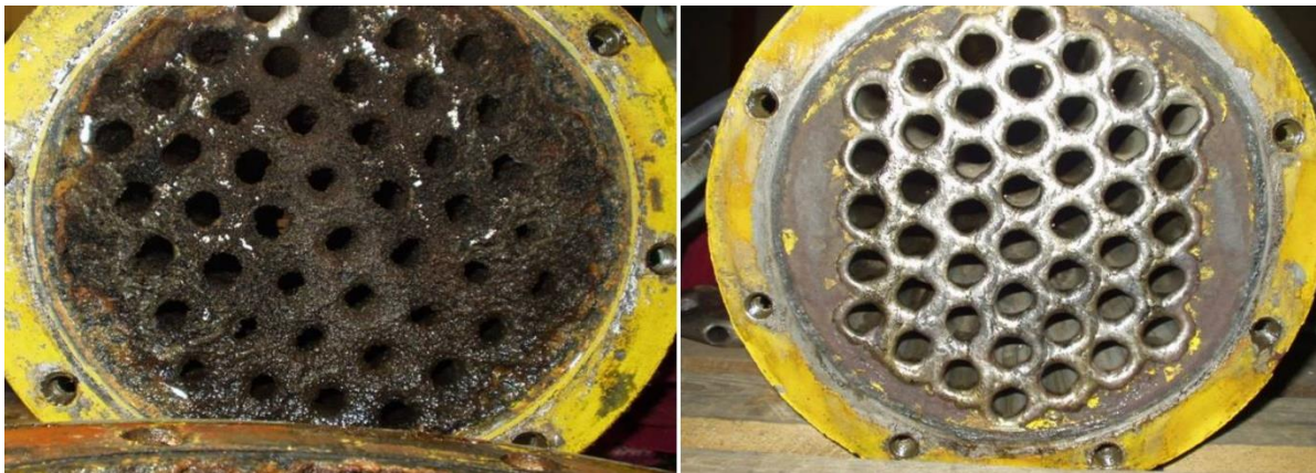
Figur 4.12: Venstre side viser et oljerør før vask med CIP-maskin, høyre side viser det samme røret etter vask (Øvre-Johnsen, 2016)
