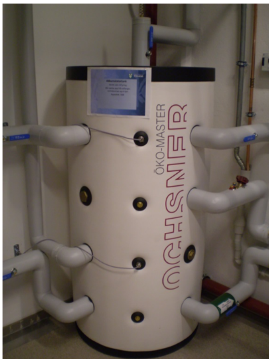
(a) Akkumulator installert på Klimalaben
