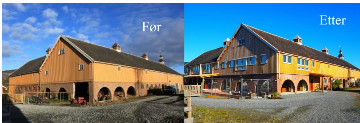
Figur 2 Medbroen gardsbarnehage før og etter rehabilitering. (Thyholt, 2015a)
