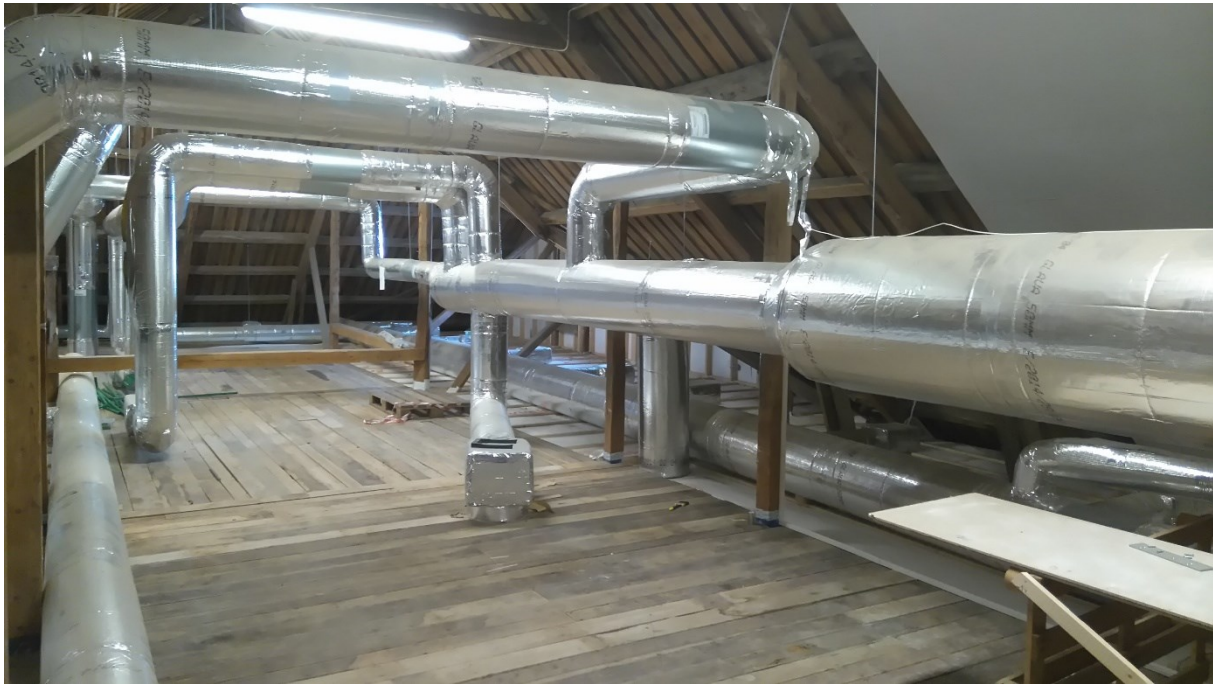
Figur 14 Bilete frå loftet som viser ventilasjonsføringane til dei ulike romma.
