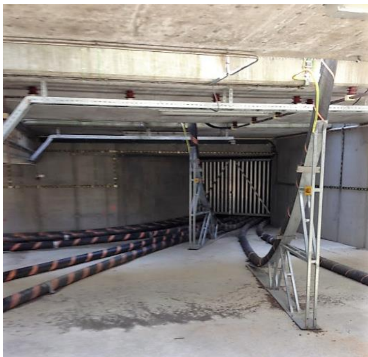
Figur 1: Inngangen til kabelkulverten i Evje
