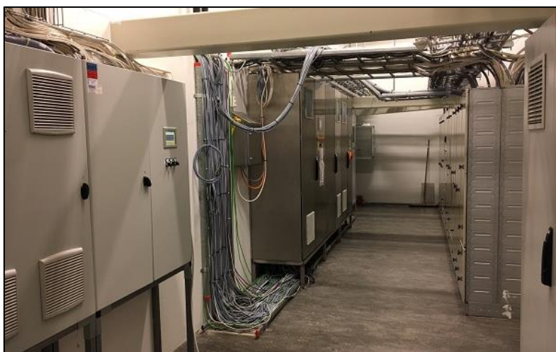
Figur 11.2 Elektriske skap er ved InnovaMar samlet i en egen seksjon på himlingen.
