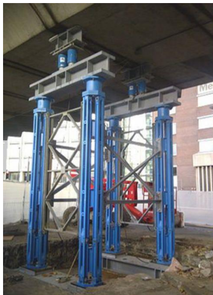
Figur 7-1 Understøttelse av bru med Superprop understøttelse.[23]
