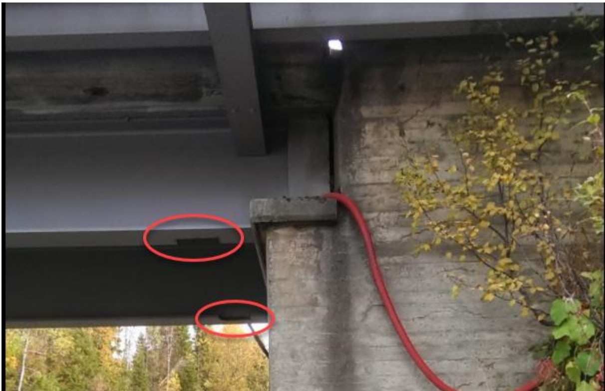
Figur 2-4 Prøvetaking av stålbjelker på Røyrvik bru i Nord- Trøndelag. Foto: Andreas Hanssen Vang
