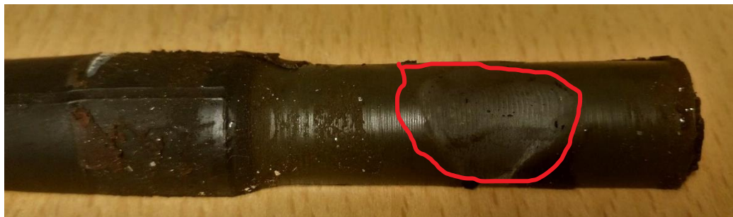
Figur 36: Bildet viser PEX-isolasjonen etter disseksjon. Det røde markerte området kan muligens ha fått et gjennomslag som vises ved misfargingen og sprøhet i materialet. På grunn av tidsmangel ble dette ikke undersøkt nærmere, og det kan derfor ikke konkluderes med at det har oppstått gjennomslag her.
