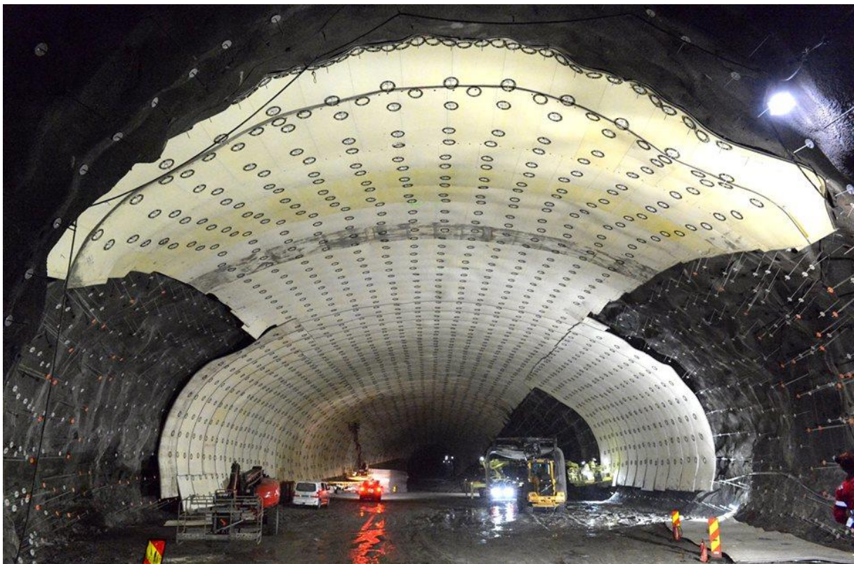
Figur 28: Montering av PE-isolasjonsmatter i entreprise E03 i Ryfylketunnelen. Disse har en tykkelse på 45 mm. Det monterings armeringsmatter over, før det avsluttes med 8 cm sprøytebetong for brannbeskyttelse (Pers. Kom., Mausset, 2017). Foto: Øyvind Ellingsen/Statens vegvesen.
