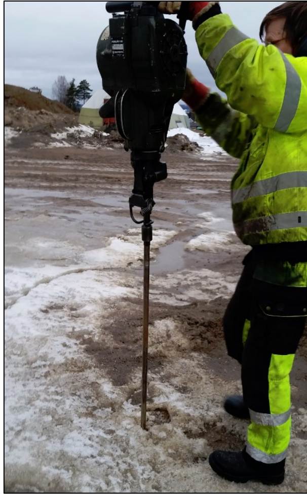
Figur 3.13: Sonderboring med pioner i Ydalir. Foto: Håvard Tømmerdal.
