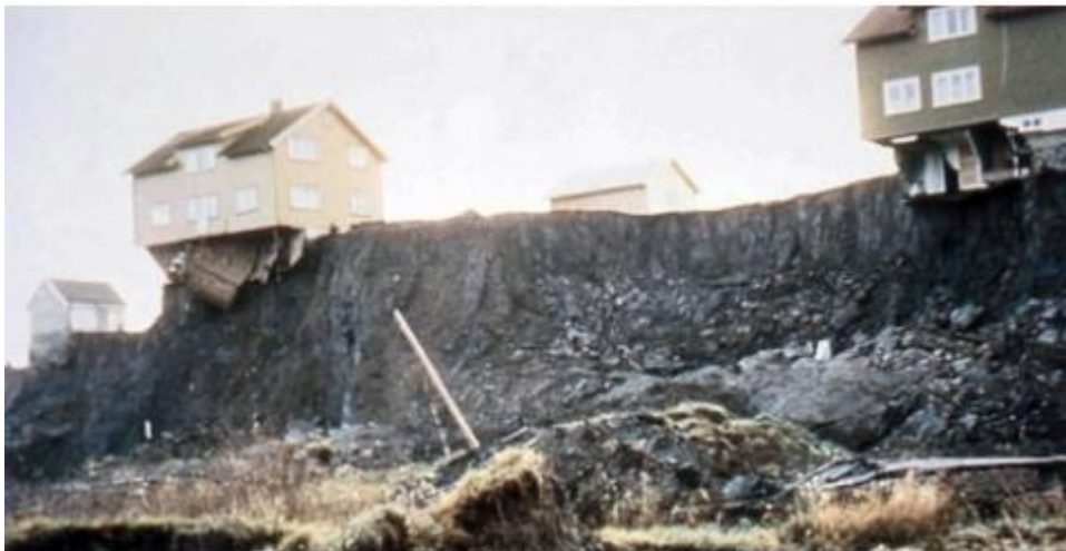
Figur 2.7.8: Kvikkleireskred i Trøgstad 1967. Innholdet av kohesiv leire gjør at bruddkanten blir svært steil (NGI, 2017).
