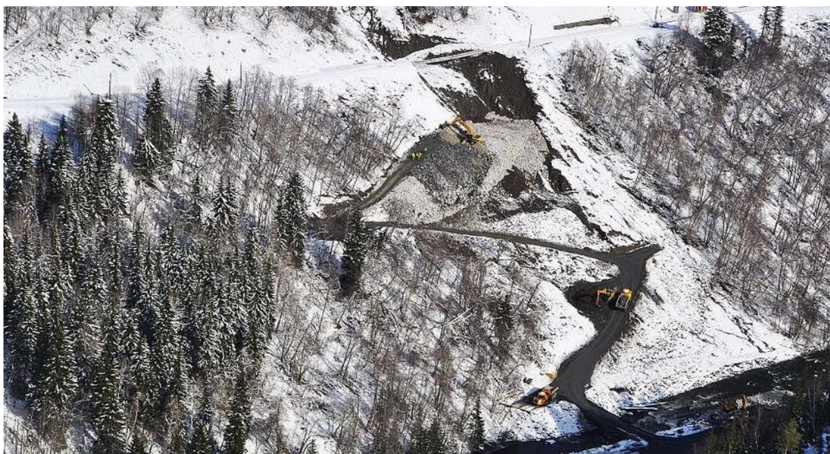
Figur 2.10.1: Jordskred i Soknedal 2012. Temperaturøkning førte til flomvann som tok med seg kvister og stein som tettet stikkrennene og førte til et jordskred (Furberg, 2012).
