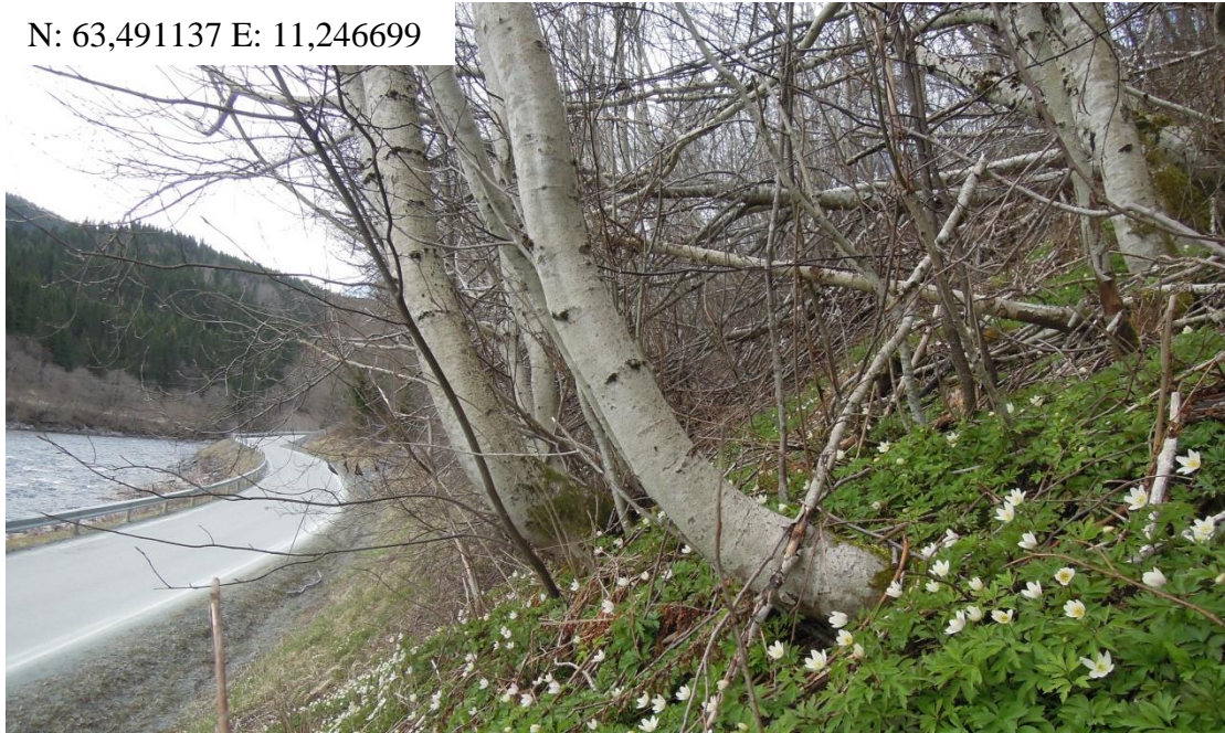
Figur 5.2.3: Bøyde trestammer i skråning som skyldes jordsig. Bildet er tatt mot vest. Foto: Benjamin Trøan (3. mai 2017).
