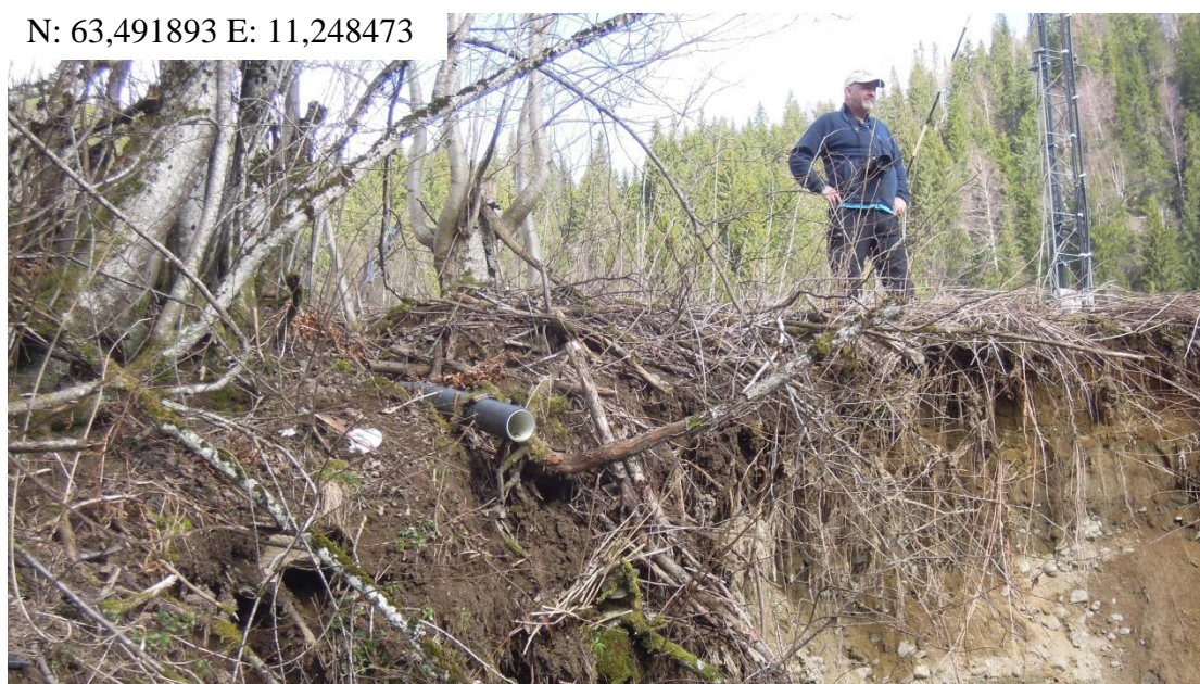
Figur 5.4.1: Dreneringsrør som har utløp ved bruddkanten. Bildet er tatt mot nordøst. Foto: Benjamin Trøan (3. mai 2017).
