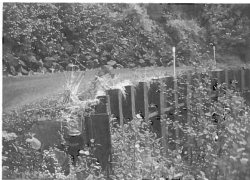
Figur 2.10.3: Spunt benyttet for å sikre veg i bratt terreng. Dette øker de stabiliserende kreftene (Sidle og Ochiai, 2006).
