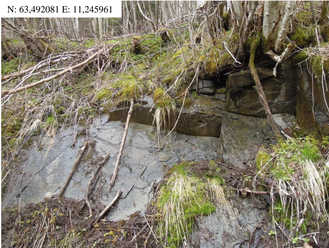
Figur 4.4.2: Leirskifer med tre sprekkeretninger. Én av sprekkeretningene faller i samme retning som skråningen. Bildet er tatt mot nord. Foto: Benjamin Trøan (3. mai 2017).
