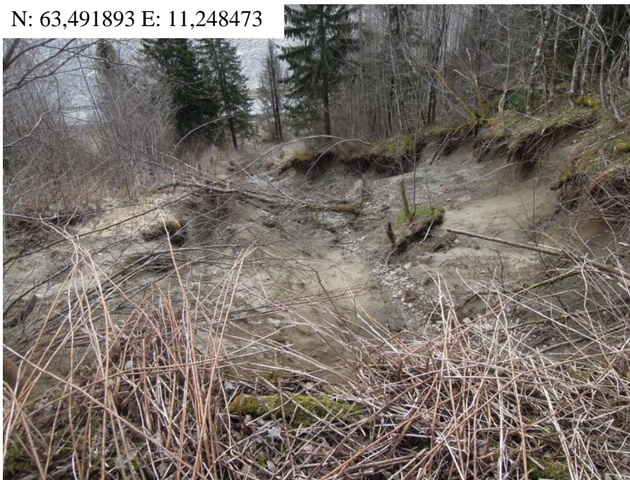
Figur 1.2.1: Skredgropa i detaljstudiet sett fra bruddkanten. Bildet er tatt mot sør. Foto: Benjamin Trøan (3. mai 2017).
