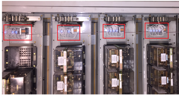
(a) Signaltegning for returkrets ved Nationaltheateret med koblingspunktet til sensorene markert (b) Sensoroppsett for tilførselskretsen, avbildet er også sporfeltreléer
