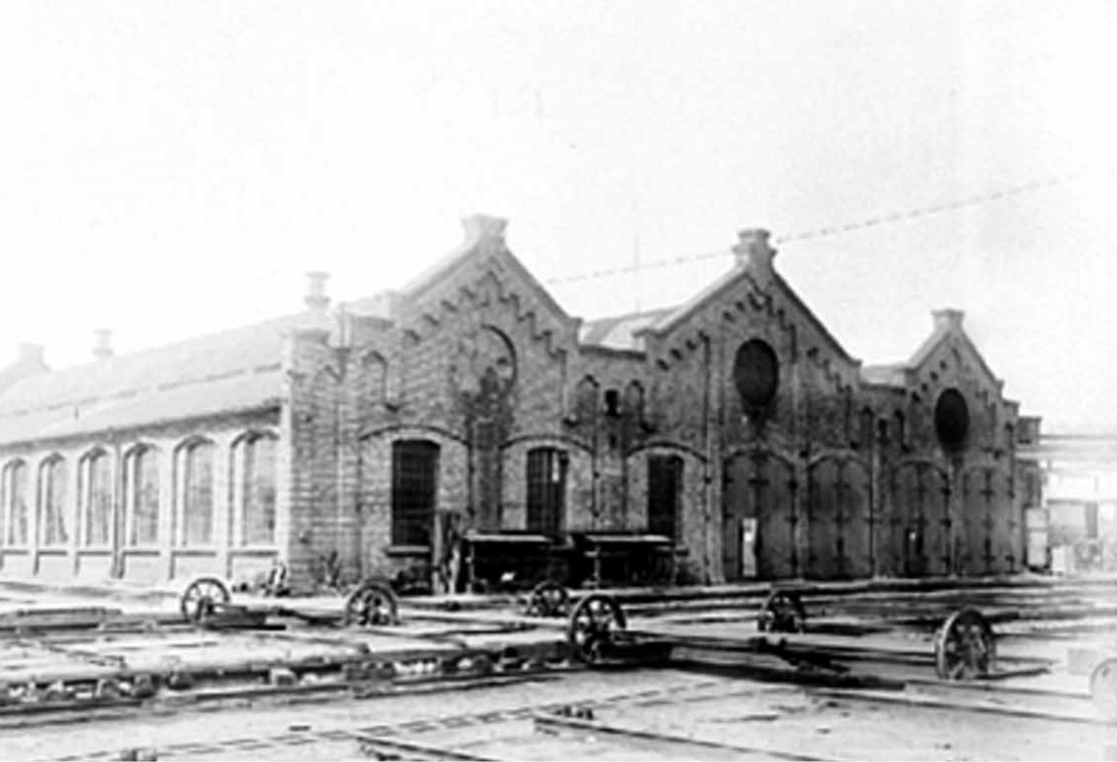
Eksteriør vogn- og presenningsverkstedet, Hamar, 1930-1935. Domkirkeoddens fotoarkiv.
