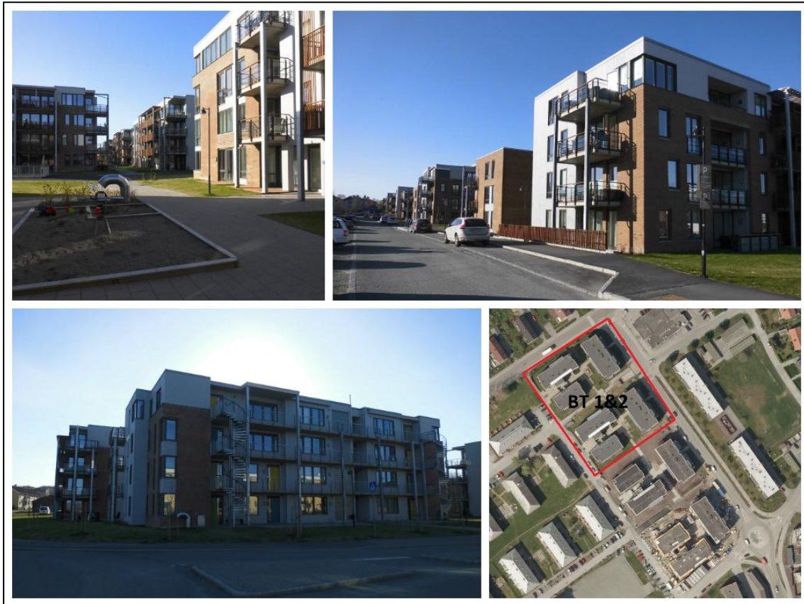
Figur 6-7 Persaunet 1&2: Bilder fra befaring og flyfoto fra Statens kartverk.
