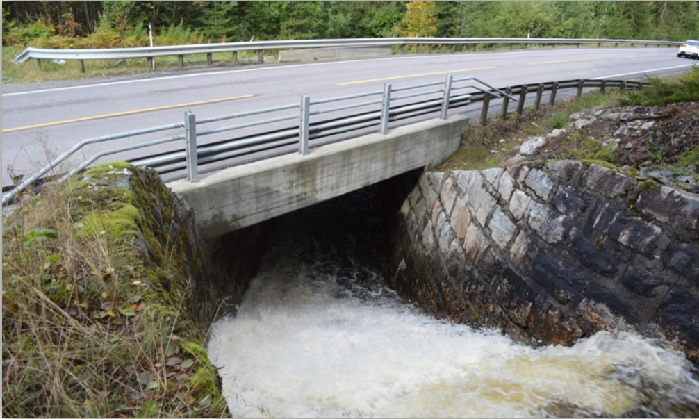
Figur 14 Natursteinsmurer oppstrøms Rv7 som har et eget preg på landskapsbildet og ønskes bevart ved utbedring av vegen i profil 10800
