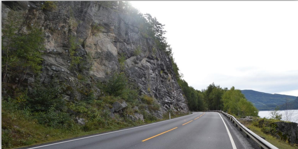
Figur 7 Høye fjellskjæringer skaper problemer på strekningen, her ved Miganberget i profil 8770
