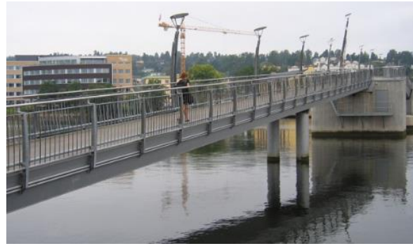
Figur 1.3: Kaldnes bru med utsikt mot Kaldnes (Aune, 2007).
