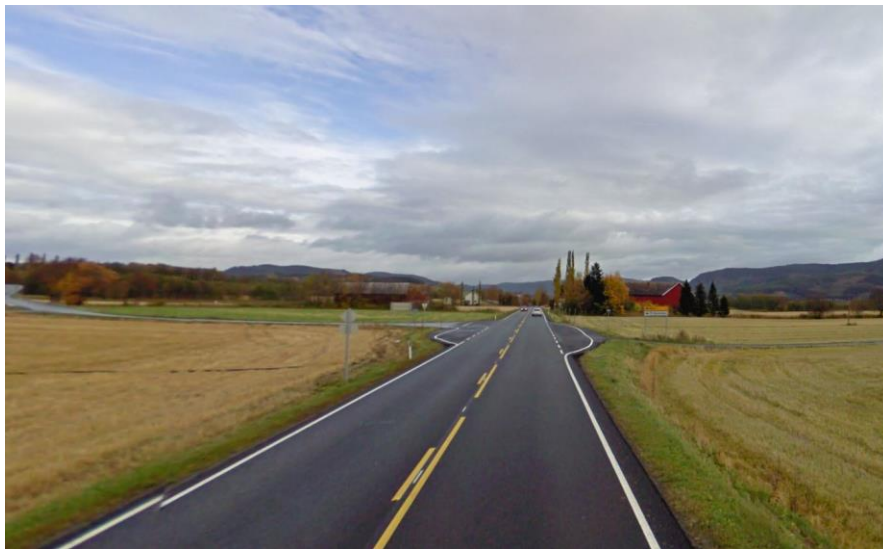
Figur 56: Oversiktsbilde over kryssområdet.
